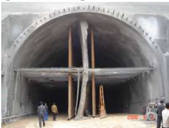
【中壁加強開挖工法】
