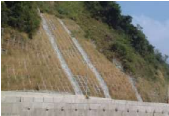
圖 4.6-10 自由型格梁及灌漿錨筋護坡
