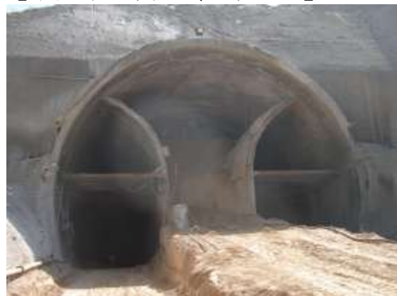
【雙側導坑開挖工法】
