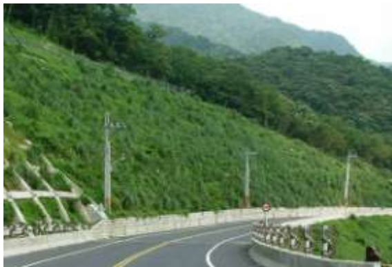
圖 4.6-11 混凝土格梁及預力地錨護坡
