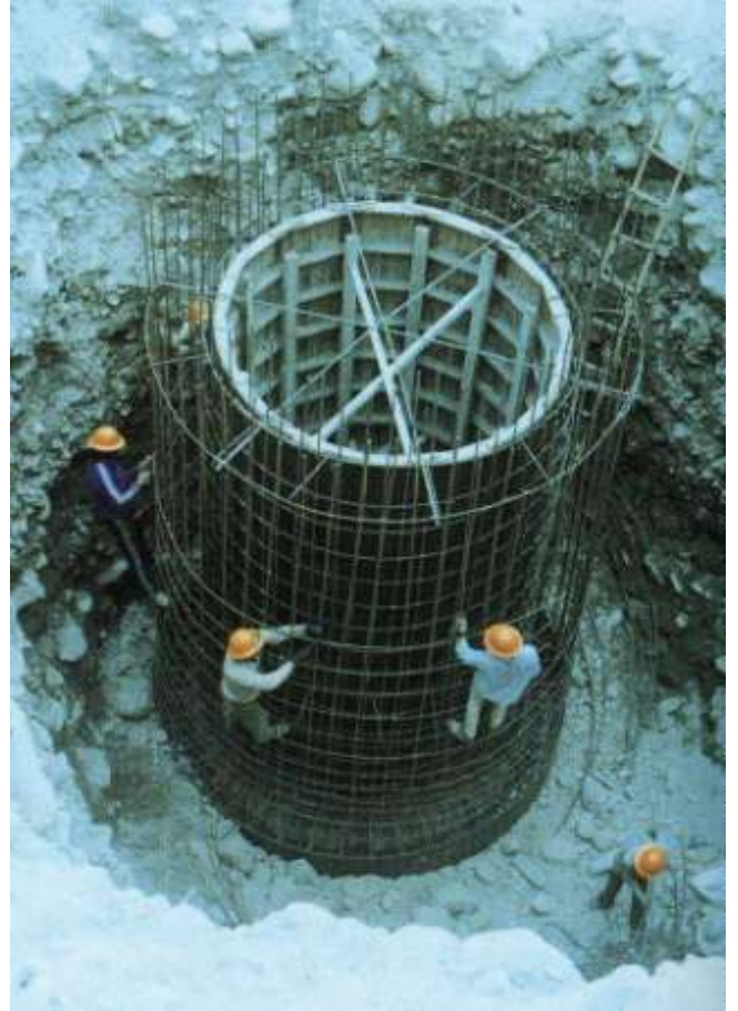
圖 4.6-7 沉箱基礎施工案例
