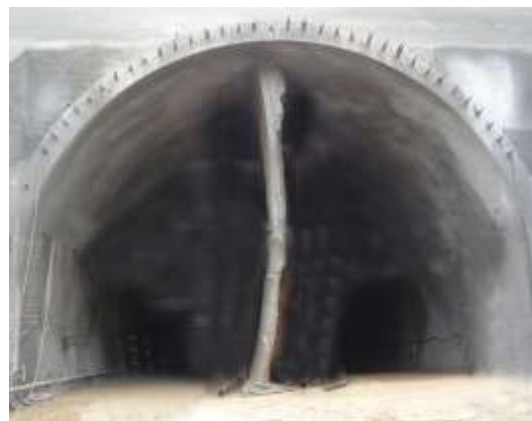
【中壁開挖（單側導坑）工法】
