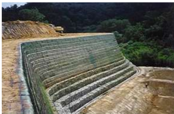
圖 4.6-8 加勁路堤邊坡型式
