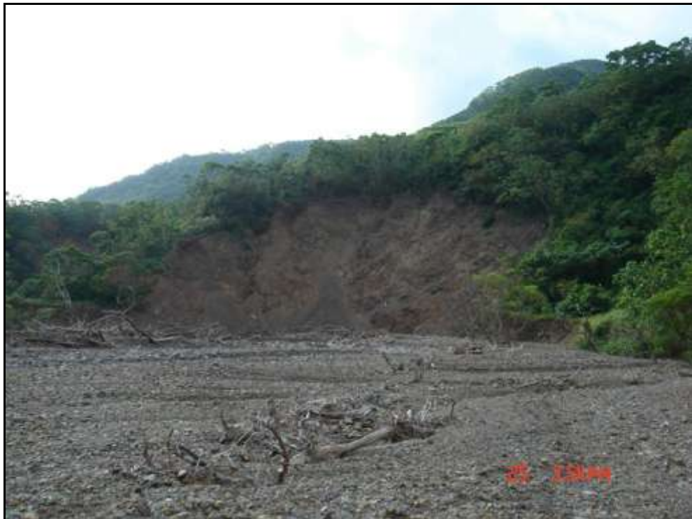
圖 2.1-11 枋山溪支流南迴鐵路施工便道所見洪流刮蝕造成邊坡坍塌現象
