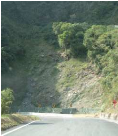
圖 4.6-12 防落石網及凸石溝護坡方式
