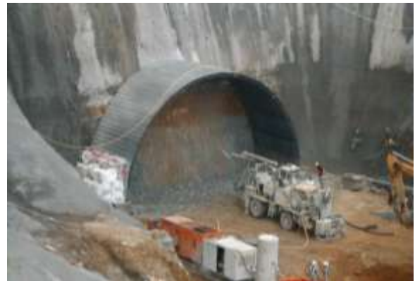
圖 4.5-9 洞口保護工施作之案例
