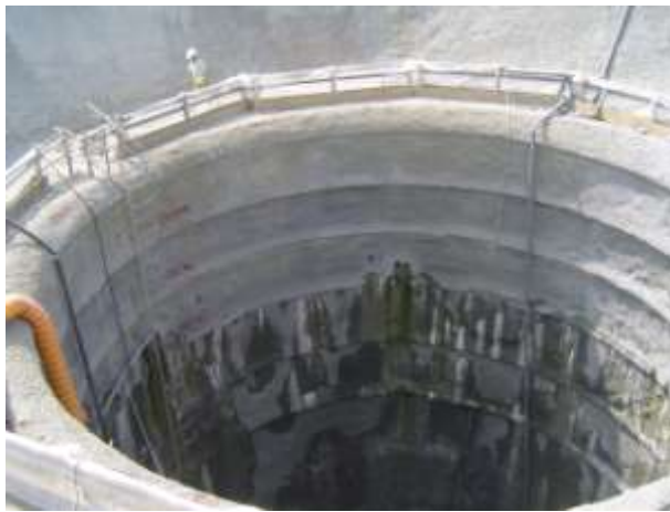
圖 4.6-6 井式基礎施工案例
