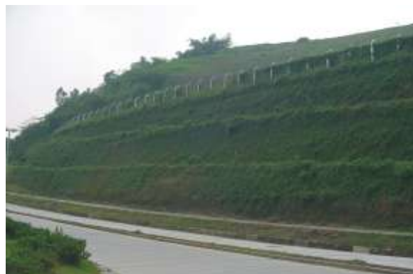
圖 4.6-8 加勁路堤邊坡型式
