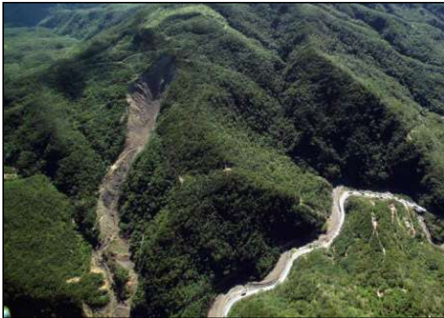
圖 2.1-10 南迴公路草埔東方因褶皺作用所產生崩場地現象
