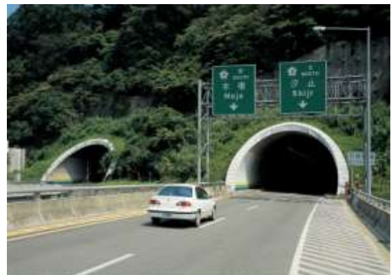
圖 4.5-11 洞口回填結構完成施作之案例
