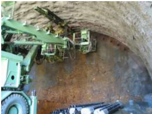
圖 4.5-8 洞口管幕鋼管施作之案例
