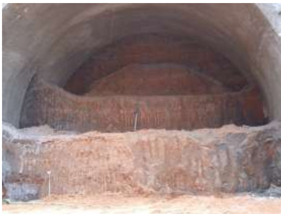
【短台階開挖工法】
