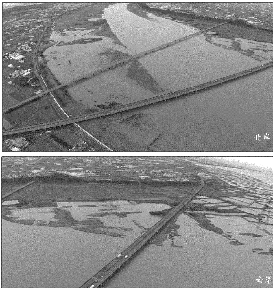
圖 1-2 台 61 線中彰大橋現況空照圖
