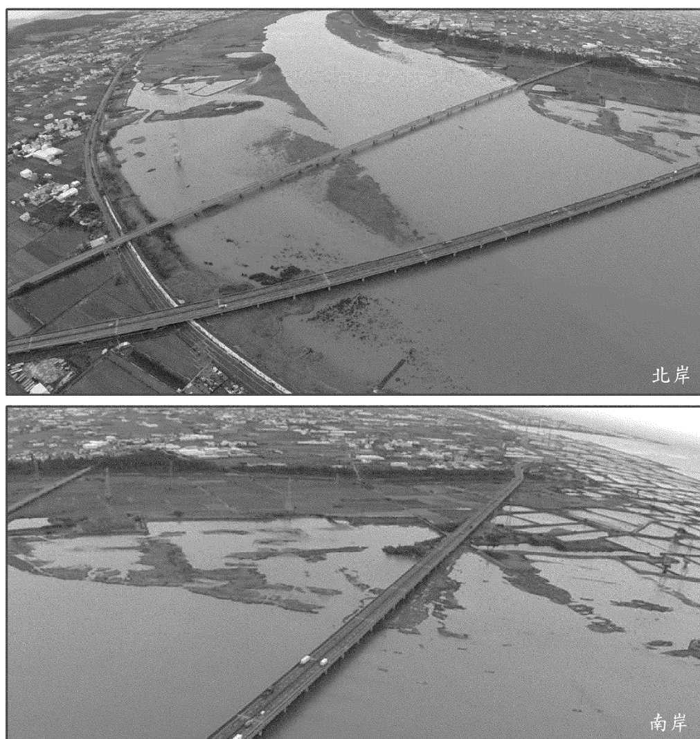
圖 1-2 台 61 線中彰大橋現況空照圖
