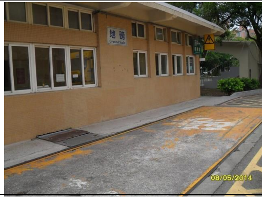
6a.地磅設備
