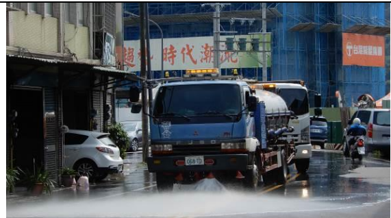
不定期於施工動線灑水
