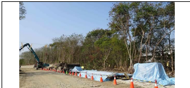
施工資材及器具堆置應放置於棧板上
