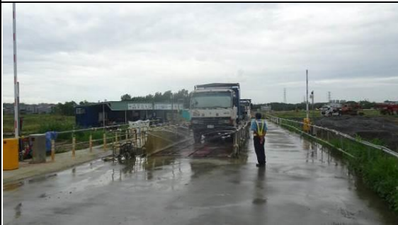
駛出工地的車輛均需清洗
