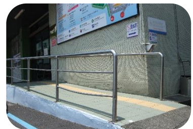
無障礙斜坡道
