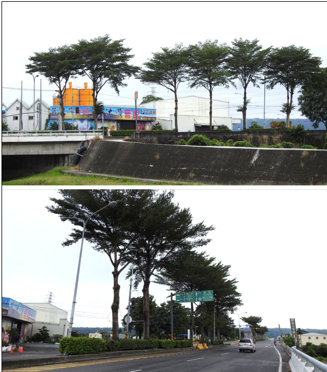
圖 10、台 14 線茄荖橋改建工程生態檢核之保全樹木施工中生長狀況照
