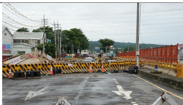
環境照-茄荖橋施工概況
