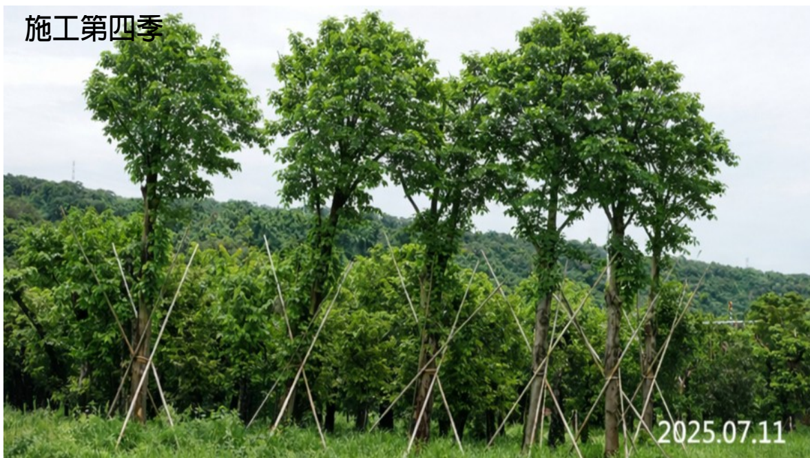
圖 10、台 14 線 13k+300 茄荖橋改建工程施工中第四季生態檢核之保全樹木生長狀況照
