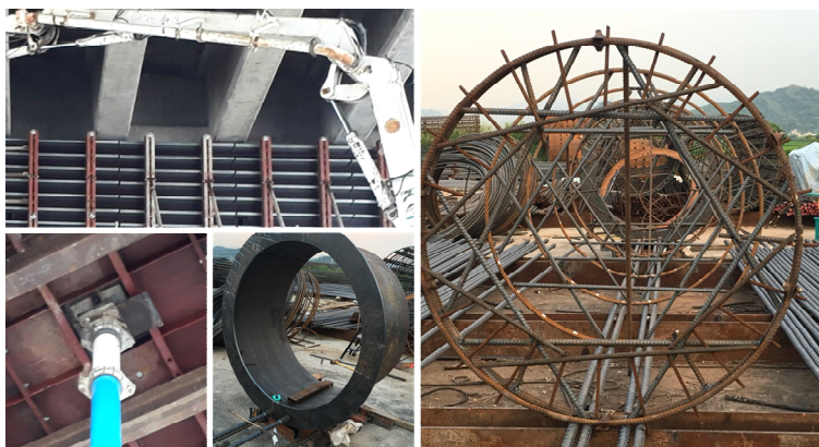
底壓式混凝土澆置工法及採用鋼筋籠主筋綁紮樣架
