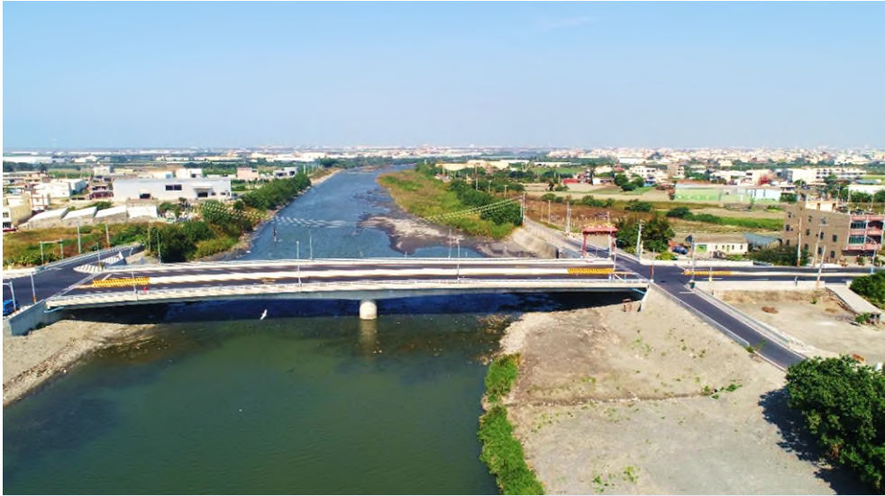
麥嶼厝橋竣工空拍圖
