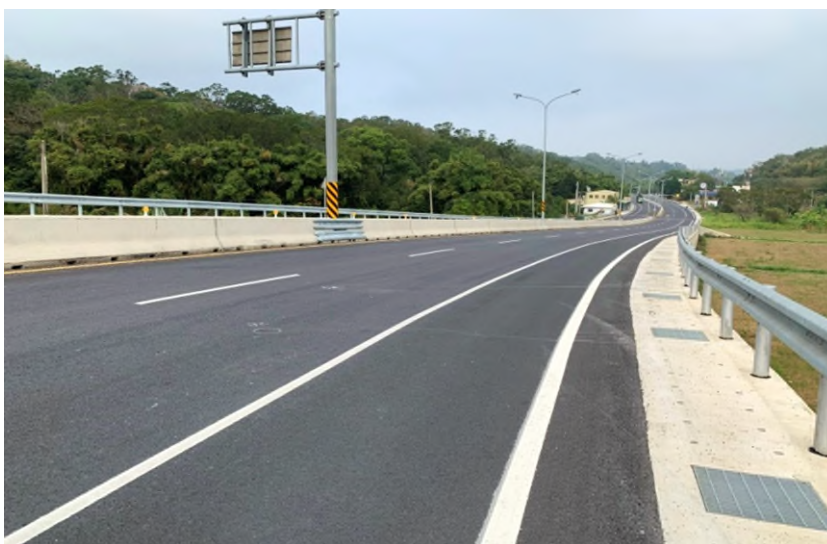
北段 ( 8K+150-9K+600 ) 改善後道路較筆直平坦、管線已完成下地
