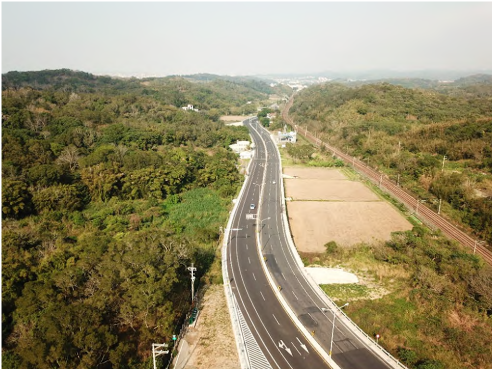
全工區完工照片-台 13 甲線 9k 路段拓寬完成
