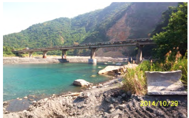
龍神橋，建於西元 1981 年，為新中橫公路闢建時期興建，新中橫公路通車後，曾在龍神橋北端（水里端）設收費站，橋型為預力 I 型梁橋
