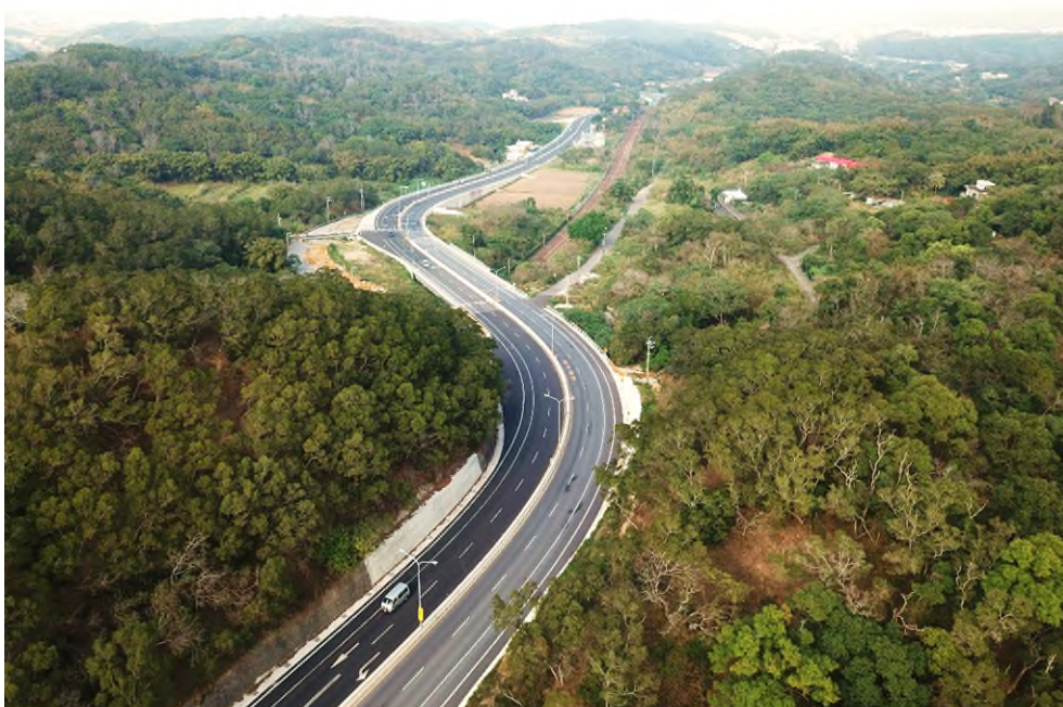
全工區完工照片-台 13 甲線豐富隧道段擴寬改線
