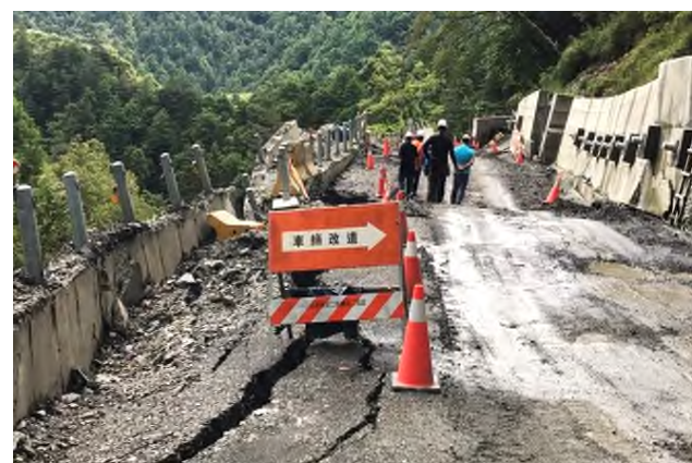
■ 8月21日/ 台8線109K+500路段大規模坍滑
