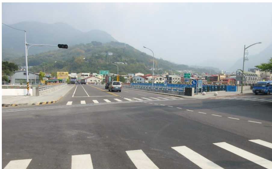
台 16 線中山橋完工通車現況
