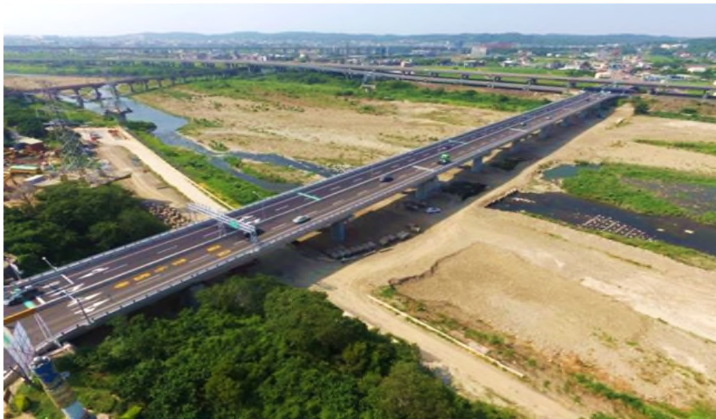
全工區完工照片
