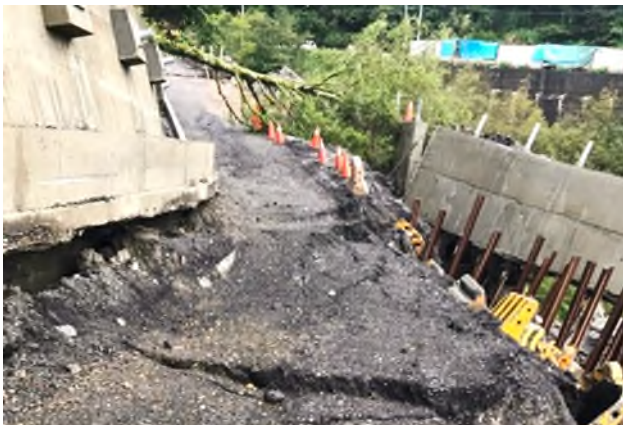
■ 8月21日/ 台8線109K+500路段大規模坍滑
