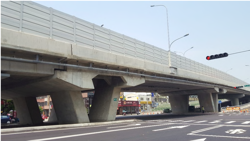
台 12 線沙鹿陸橋完工
