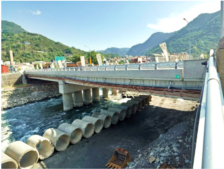
台 16 線中山橋完工通車現況
