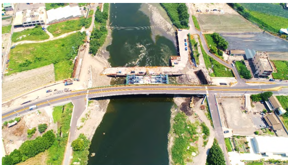
工區規劃半半施工
