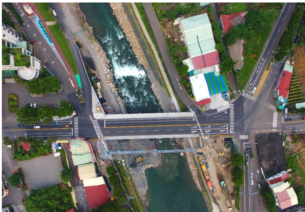
全工區完工照片
