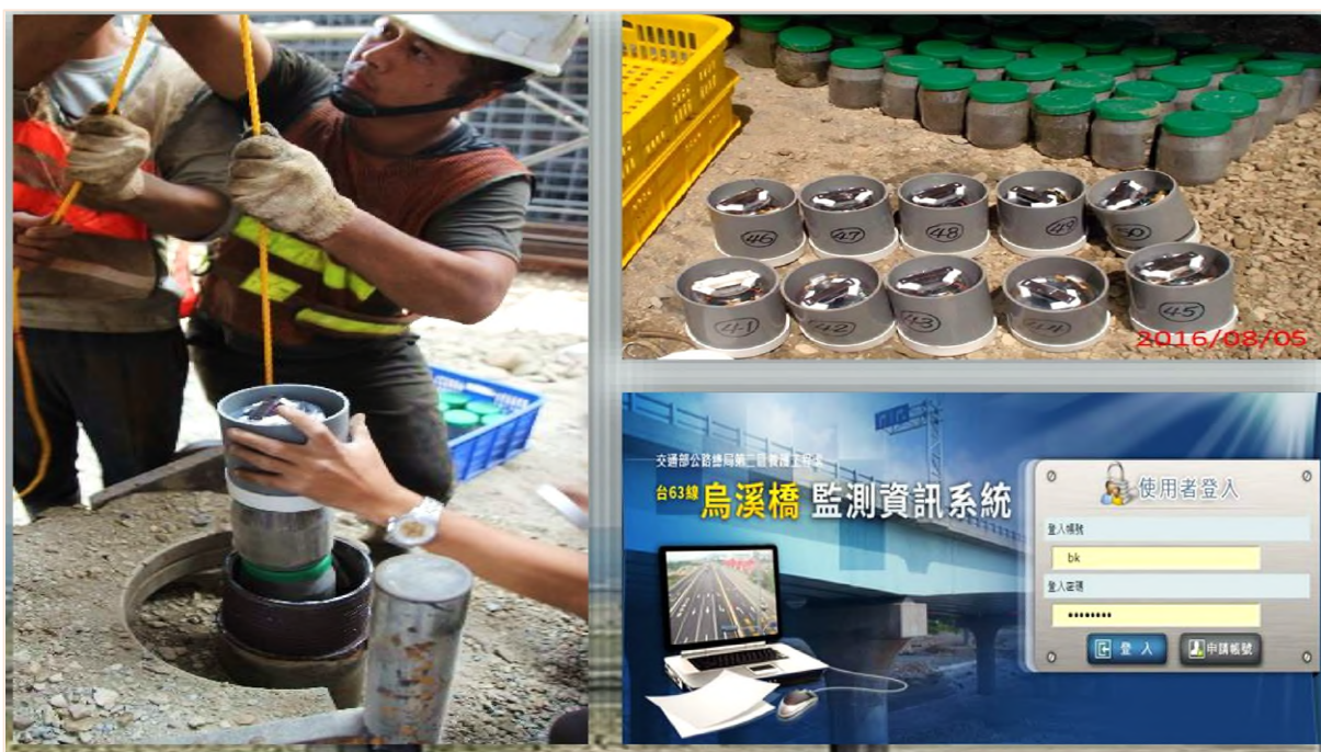
台 63 線烏溪橋監測資訊系統（無線追蹤粒子）
