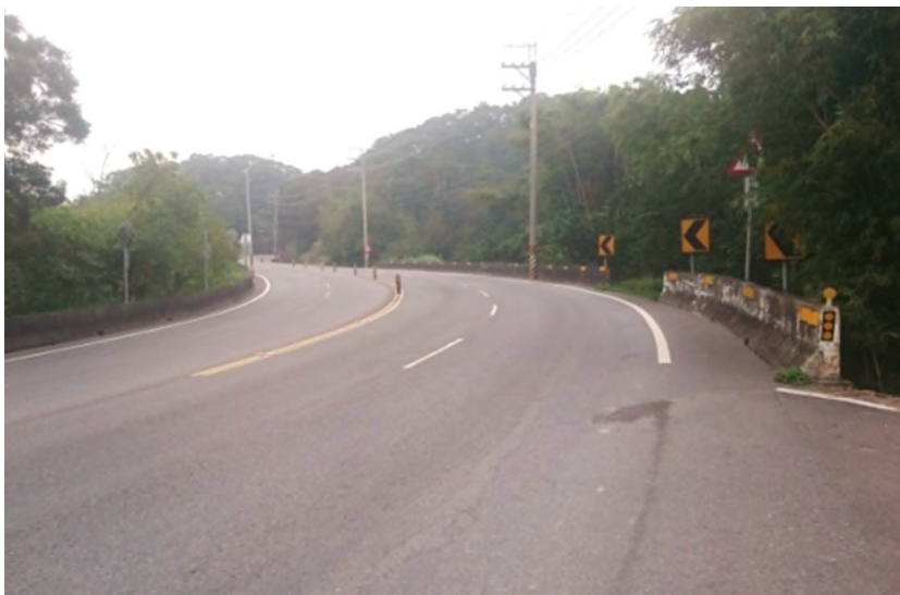
北段 ( 8K+150-9K+600 ) 改善前道路蜿蜒曲折、電線電桿林立
