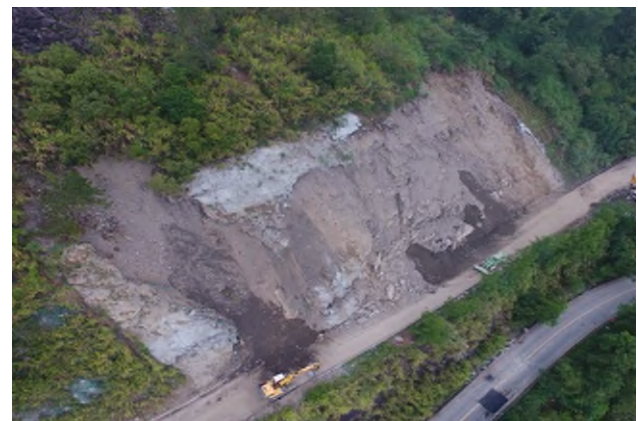
■ 6月18日/台21線133K~134K路段既有噴凝土護坡發生崩塌損壞
