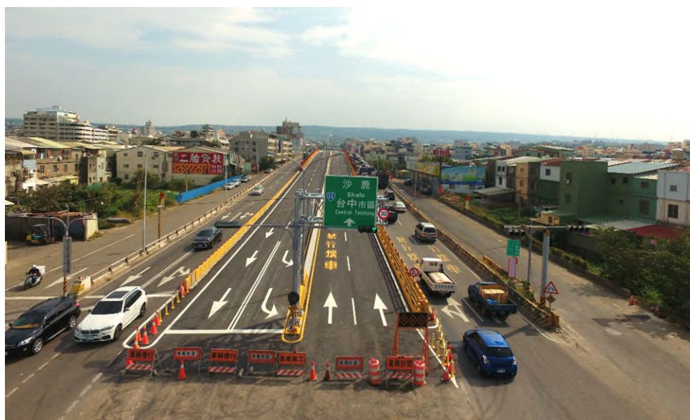
第一階段匝道完成空拍
