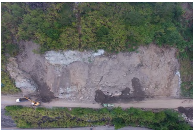
■ 6月18日/台21線133K~134K路段既有噴凝土護坡發生崩塌損壞
