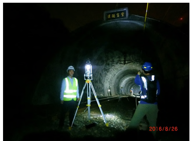
鐵路隧道內監測
