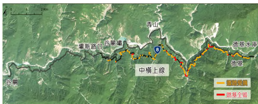
中橫上線路基全毀位置多達 16 處共 2,029 公尺
