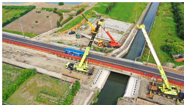
並列式箱型梁吊裝
