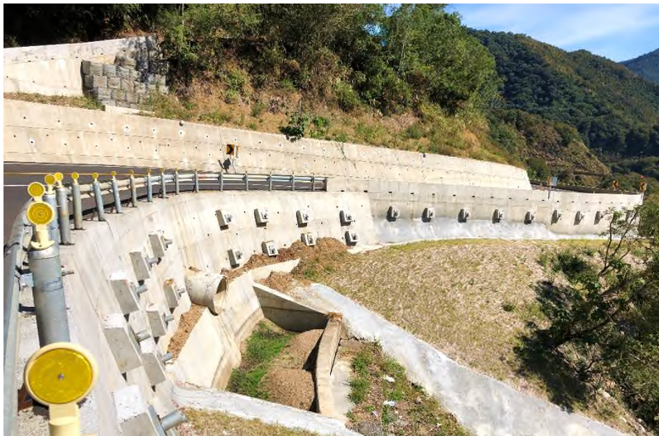
靠河側地錨擋土牆及消能池完工
