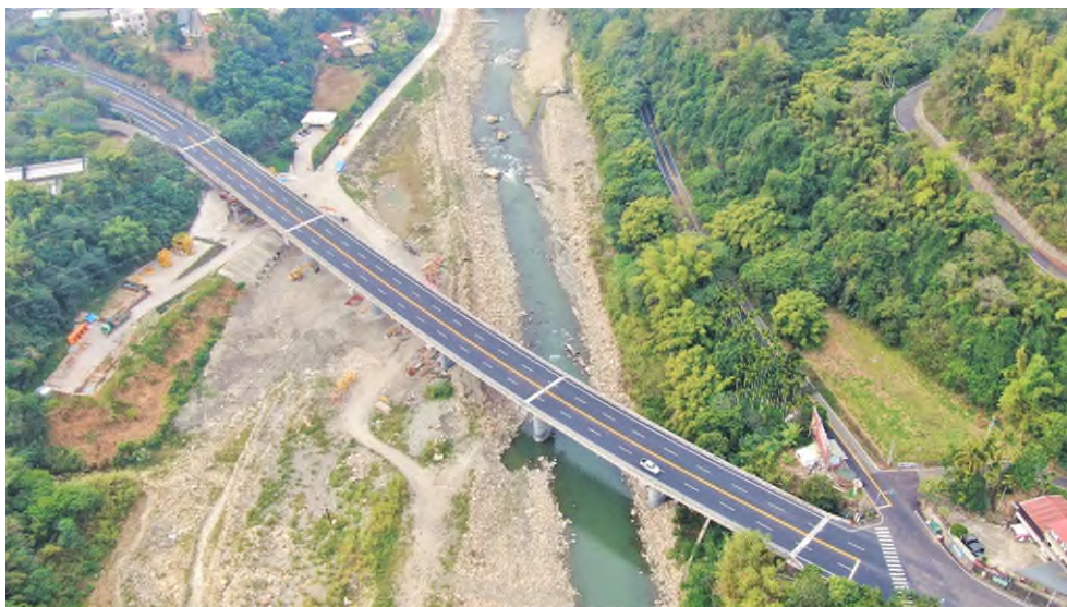
育樂橋 P4 至 P6 橋基改建工程施工照片
