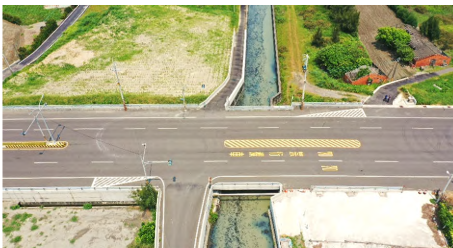
三豐橋竣工全區照片
