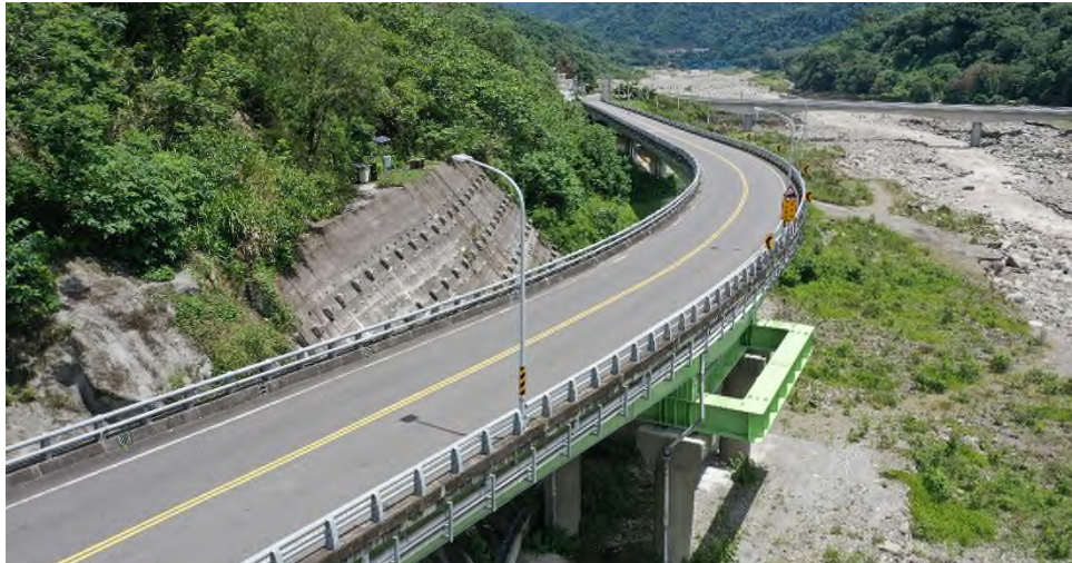
全工區完工照片
