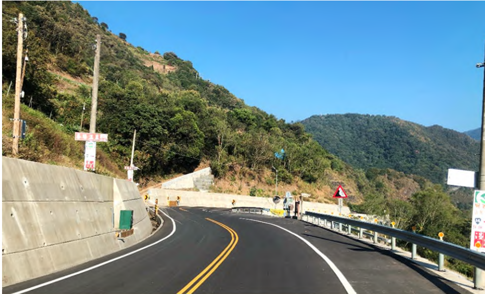
路面及靠山側擋土牆完工
