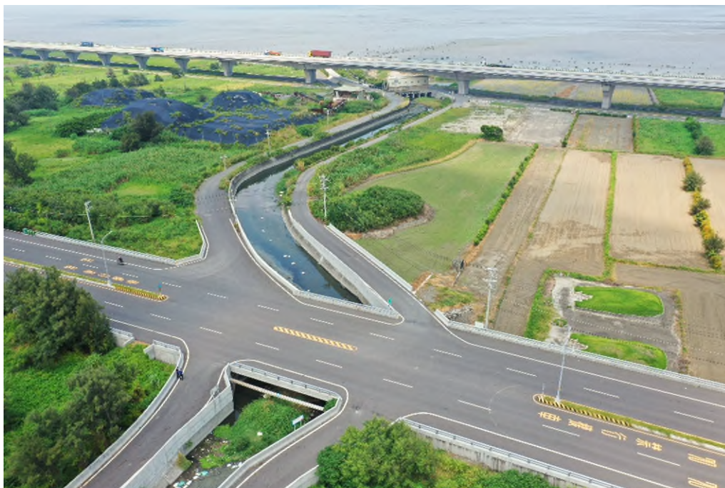
新街橋竣工全區照片
