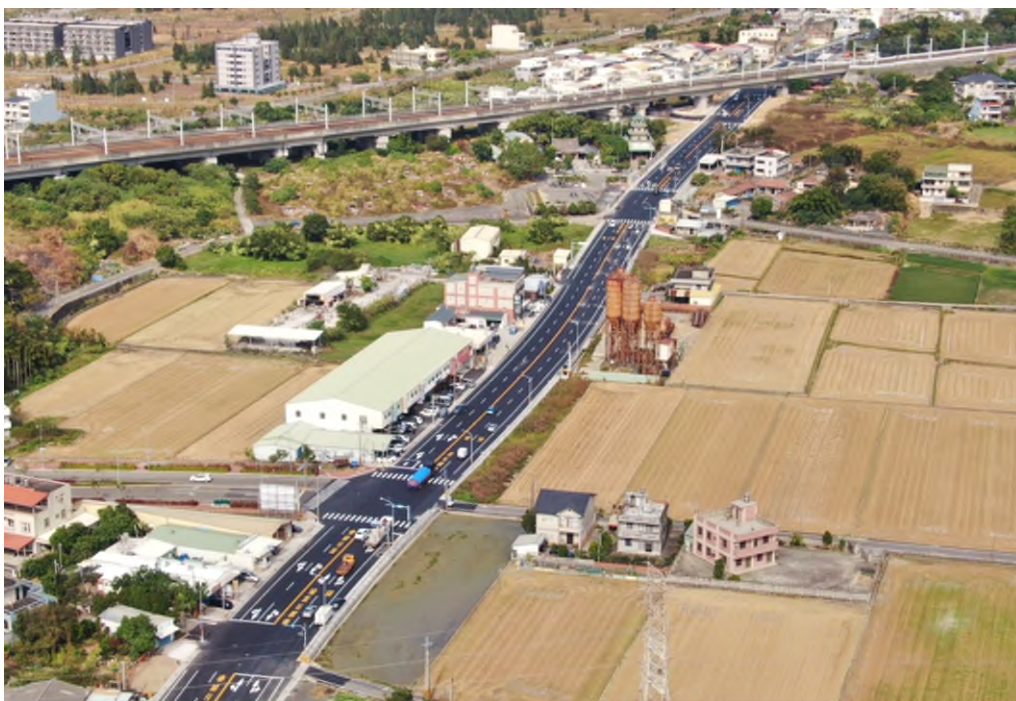
台 13 甲線 12K 處完工
