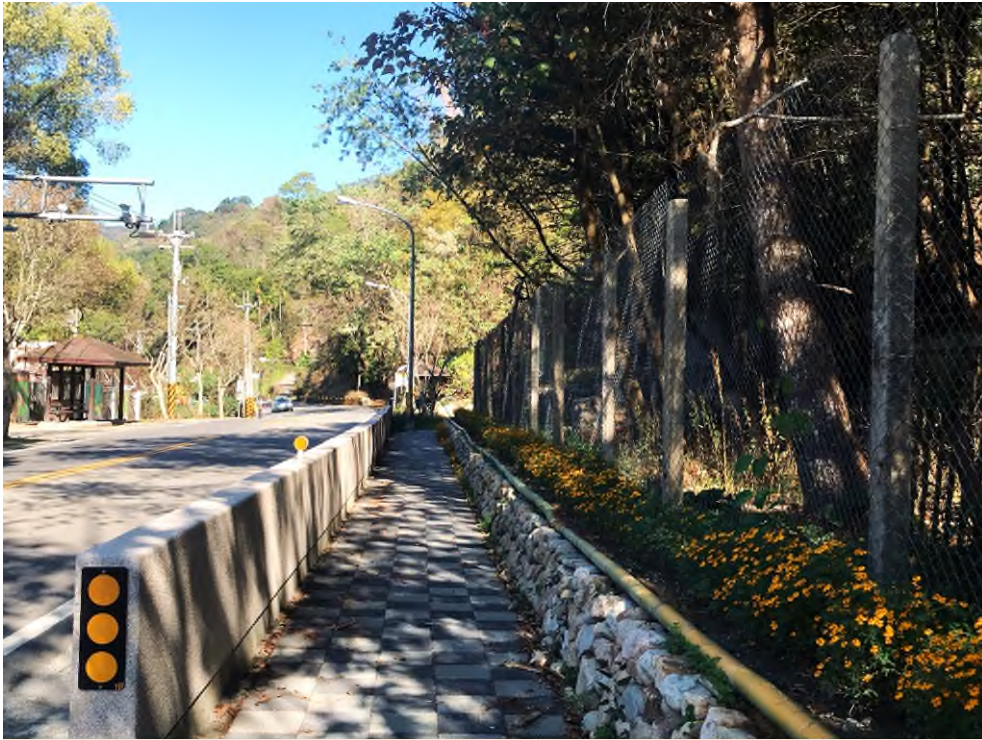
砌成多孔隙塊石矮牆加安全透水步道
