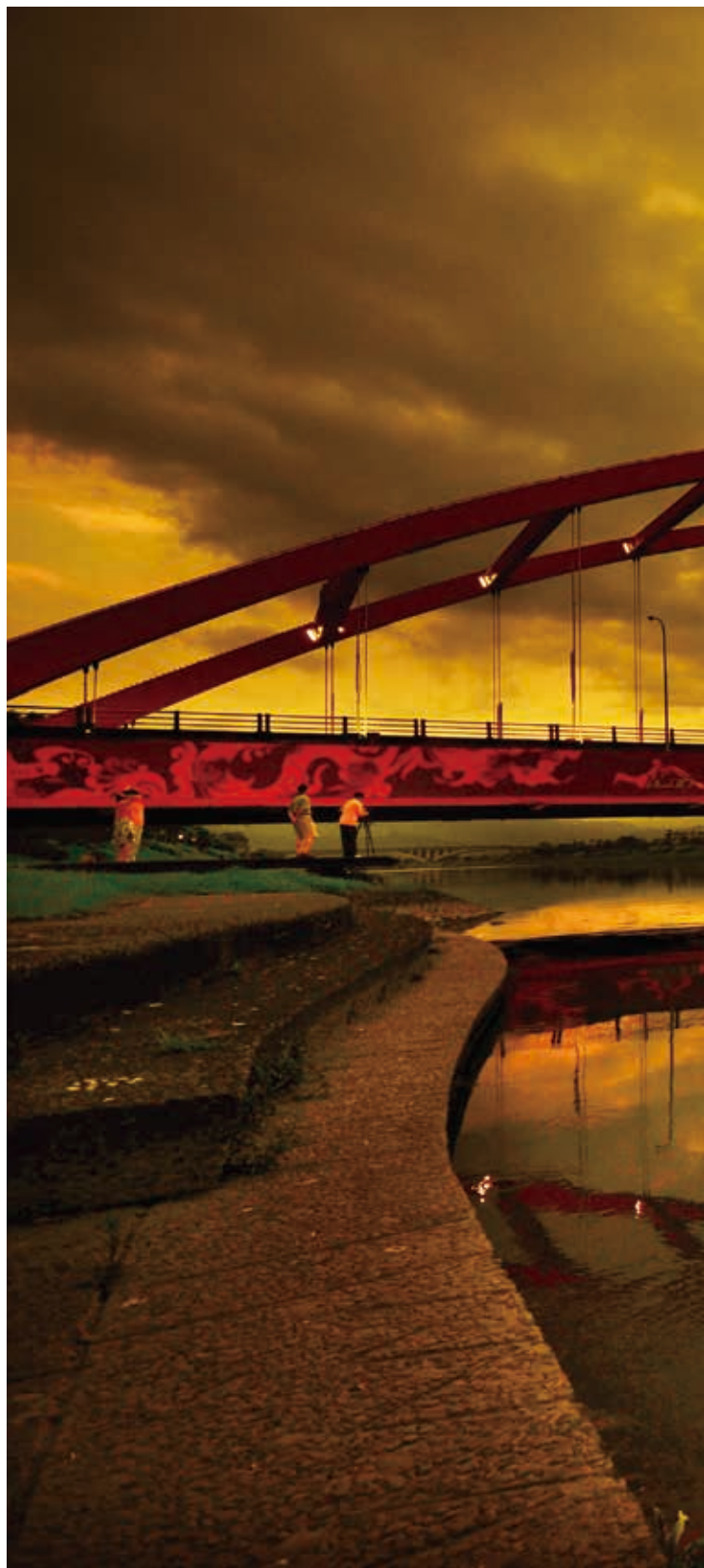
台7丙線利澤簡橋
