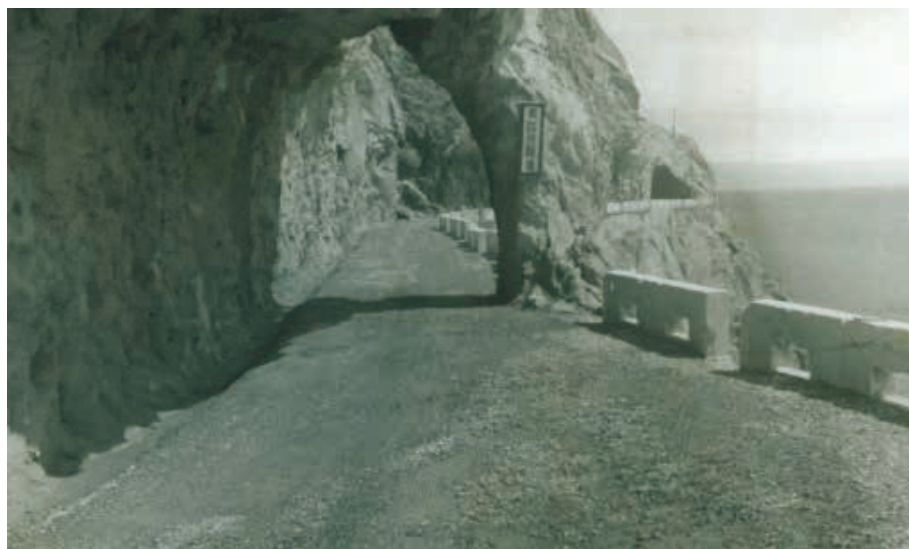
早期蘇花公路台9線175k-176k，第四號隧道景觀（四工魏貽新先生提供）
