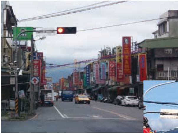
東港路拓寬前
