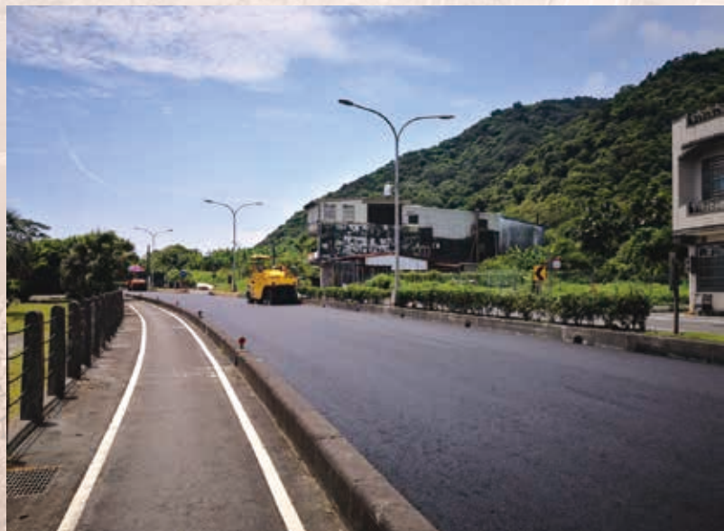
改質瀝青混凝土路面滾壓施工
