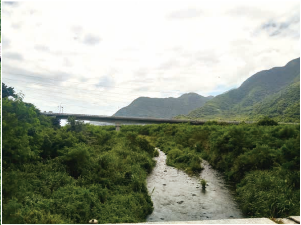
跨越東澳北溪的東澳橋
