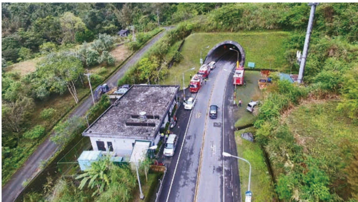
玉長隧道西洞口，人車集結進行災防演練
