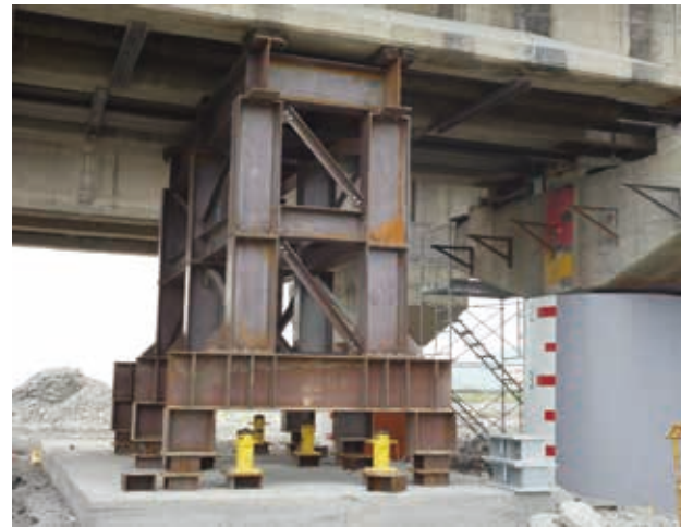
鋼構支撐橋面
