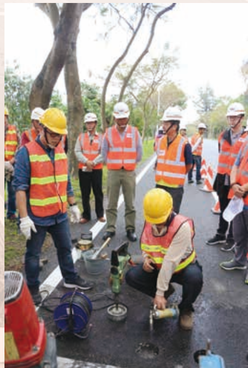
瀝青磚施作現況
