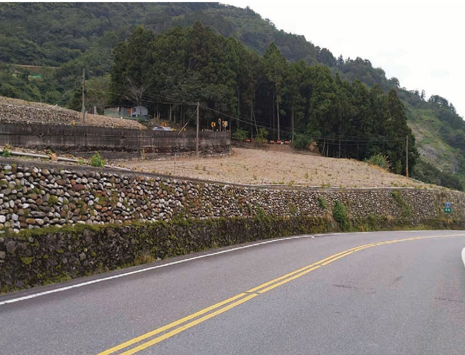
台7甲線南山路段砌石護坡
