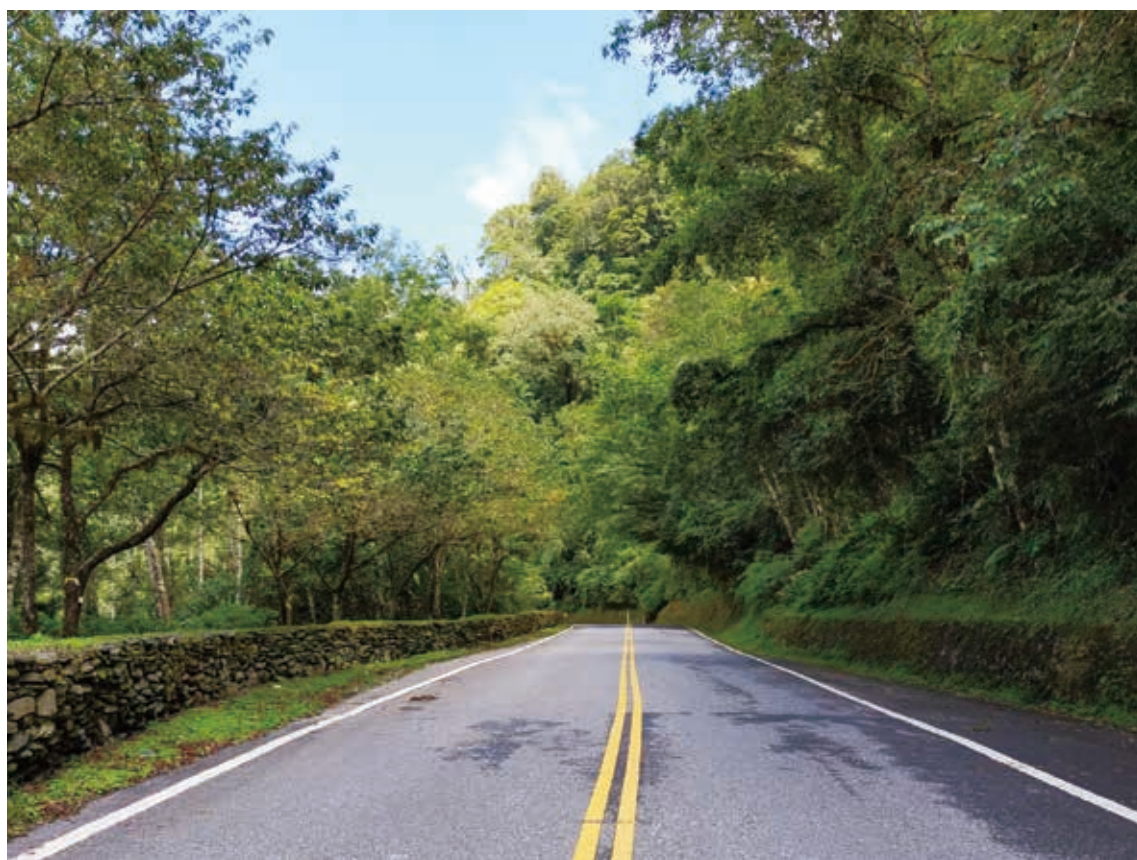
台8線129k神木路段砌石護坡
