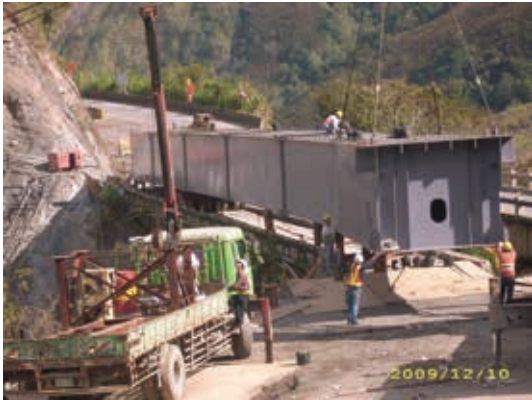
則前橋鋼梁吊裝
