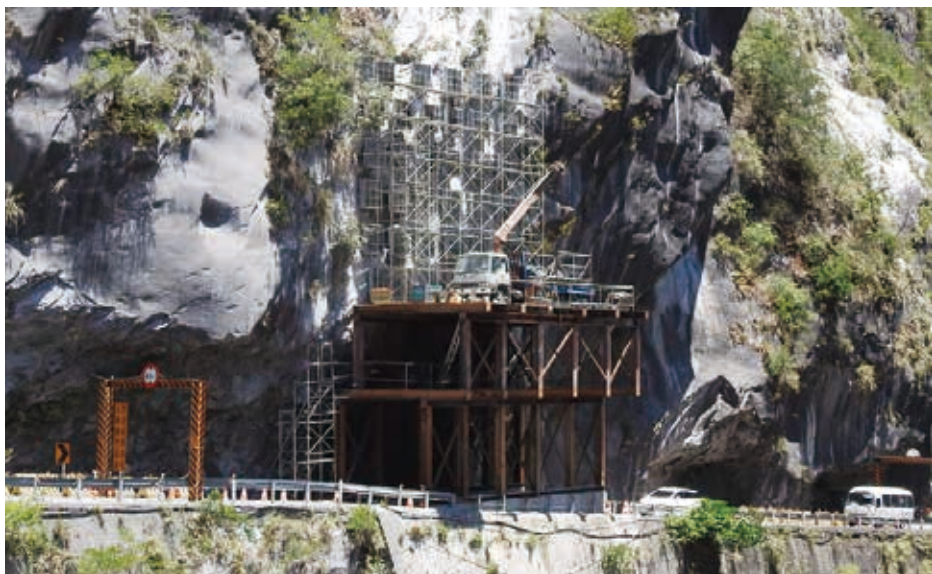
施工中的鋼構洩槽
