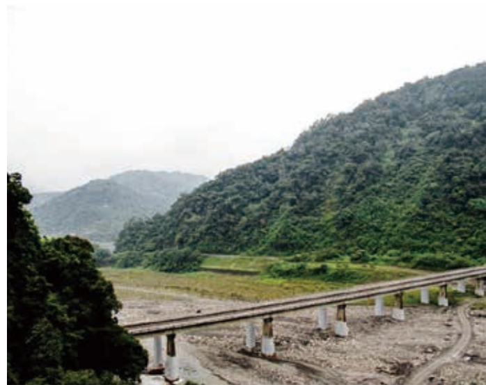
舊家源橋的現況
