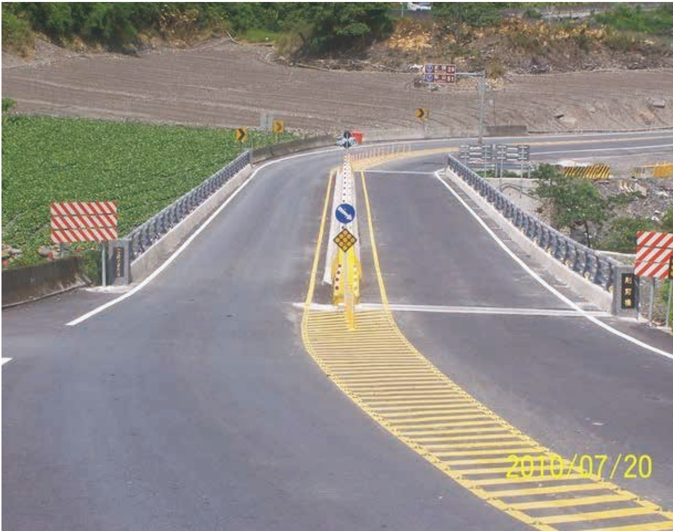
則前橋完工後照片
