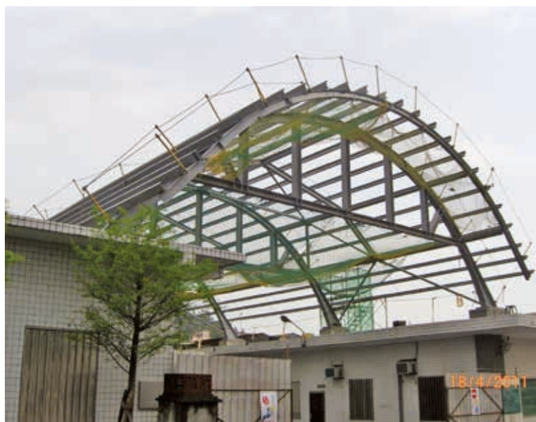
文物館外遮風擋雨的支保鋼構，當時施作之情況
