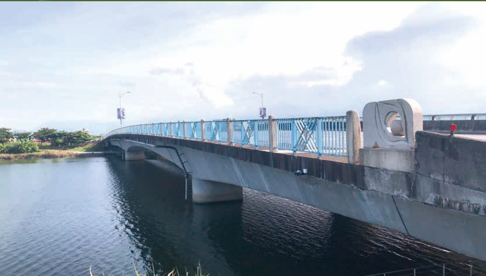
石雕意象搭配著淺藍色欄杆，賞心悅目的加禮遠橋
