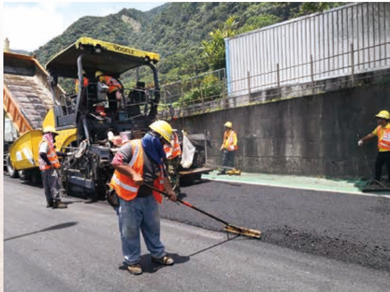
改質瀝青混凝土路面鋪施工
