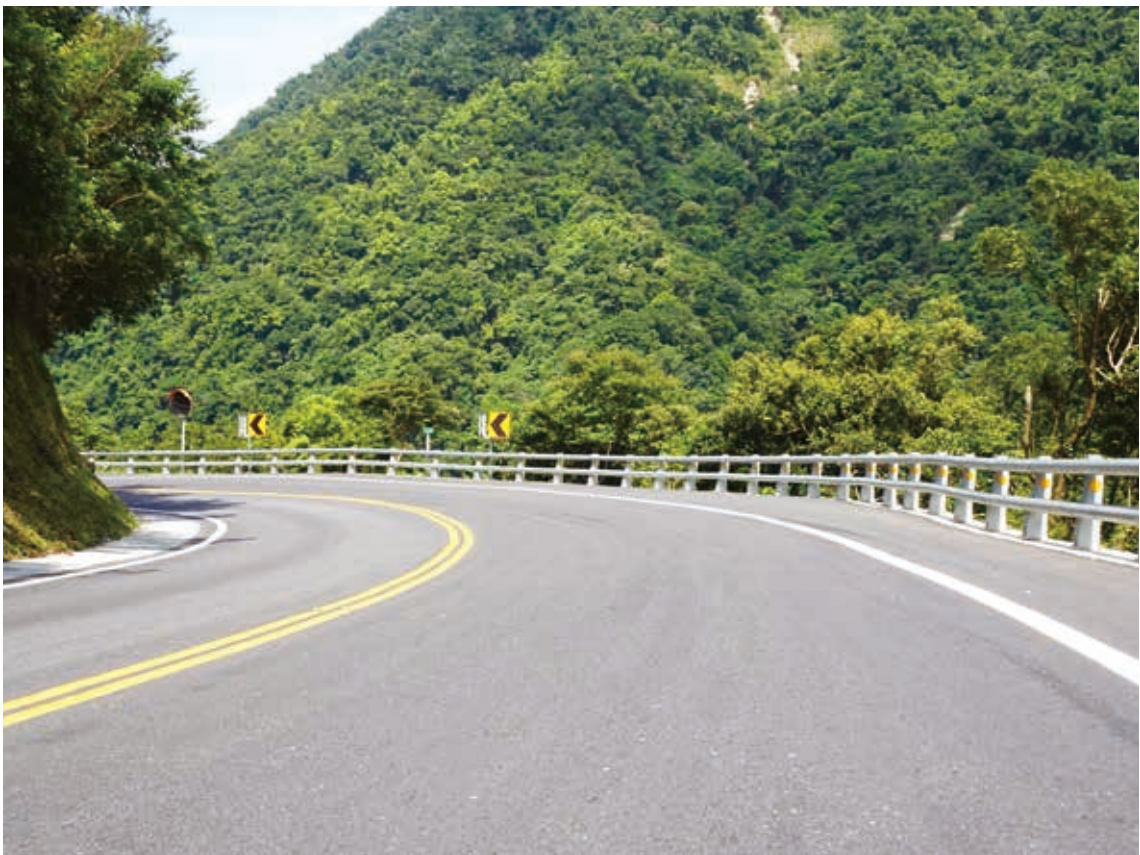
台9線新澳隧道南端路段
