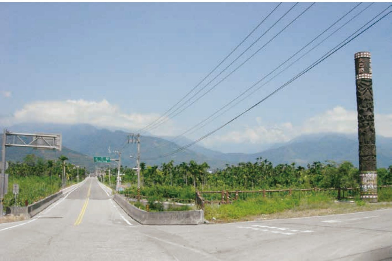
台11甲線東富田橋路段
