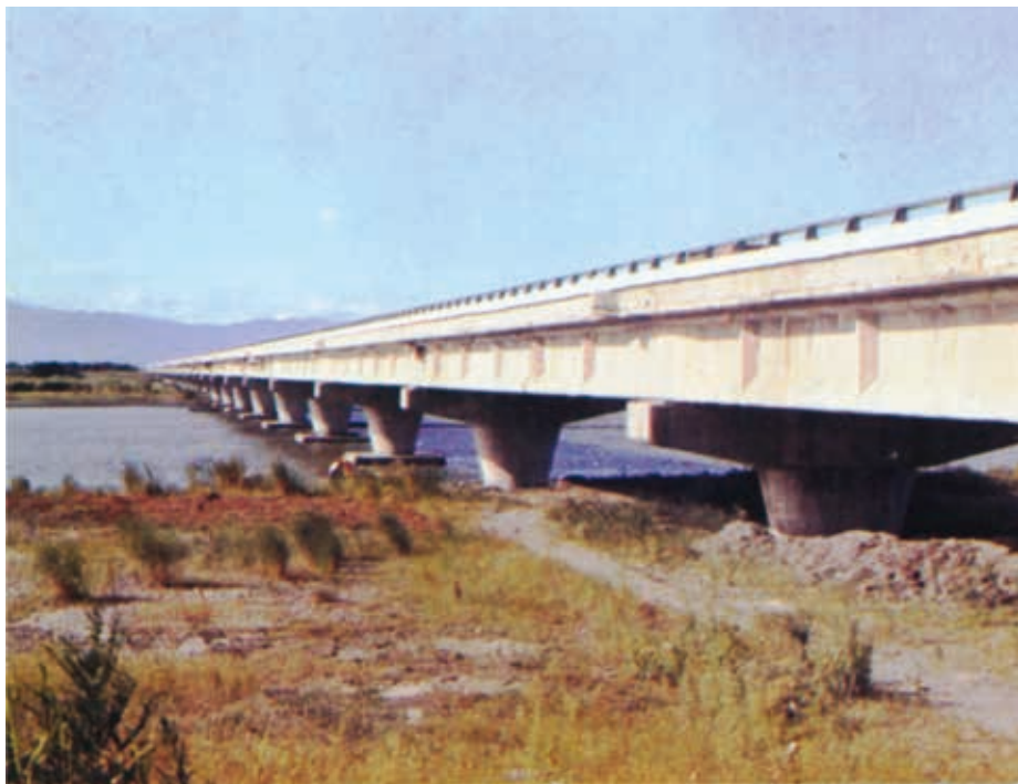
台2線噶瑪蘭橋
