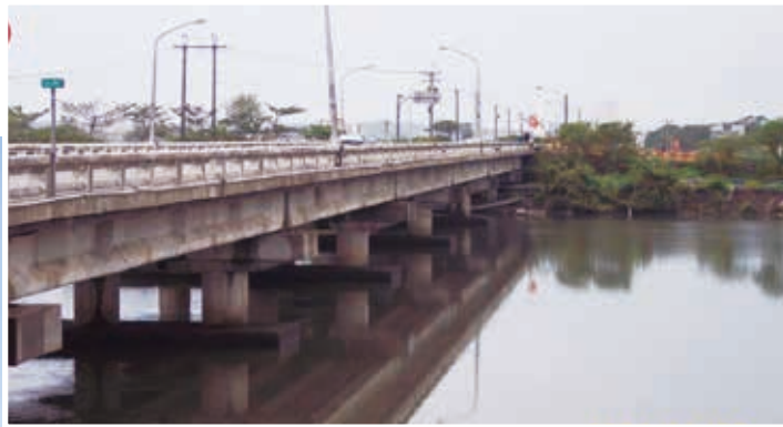
台2線加禮遠橋民國98年改善前現況
