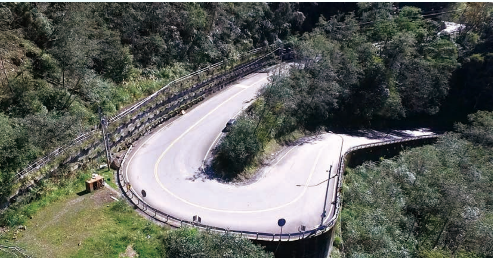
台7甲線41.7k迴頭彎改善後照片
