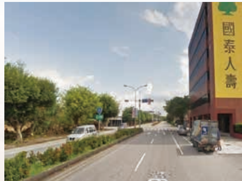
台9線239k(鳳林外環道，鳳林鎮信義路) 剝脫試驗路段
