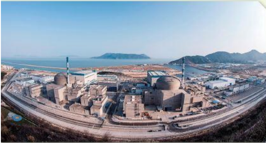
位於中國大陸廣東省濱海處的台山核電廠，分兩期建造，是「中」法合作的大型核電廠。(Photo Credit: EDF Energy, https://commons.wikimedia.org/wiki/File:Taishan_Nuclear_Power_Plant.jpg )
