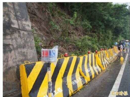
南迴台九線413.5公里山壁坍方，搶修工作人員以紐澤西護欄作阻絕，防災情擴大。(記者陳賢義攝)
