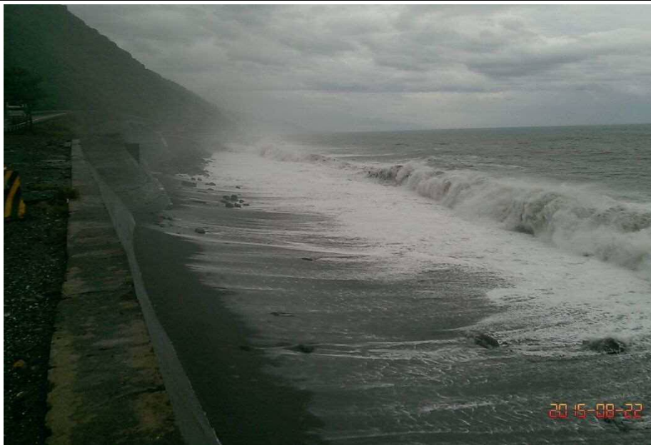
台9線多良-大竹路段東北季風海浪襲擊緊鄰台9線道路情形
