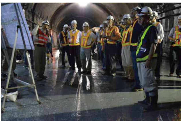
圖 3-7 101 年 6 月 27 日第 5 次推動小組委員視察 B2 標工地
