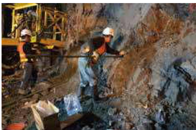
圖 3-9 隧道全能工班施工情形一
