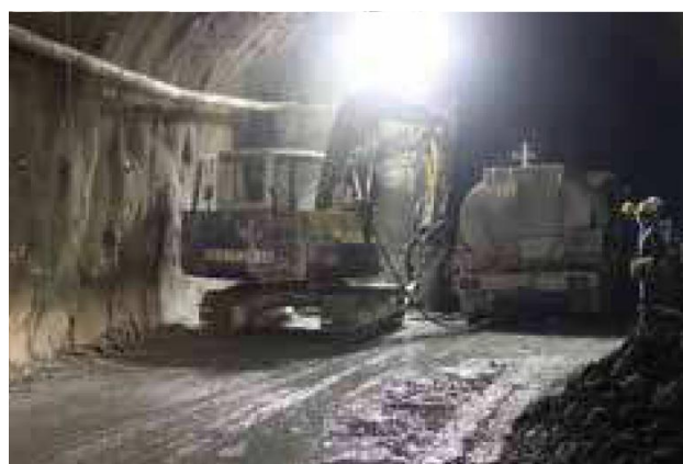
圖 3-10 隧道全能工班施工情形二
