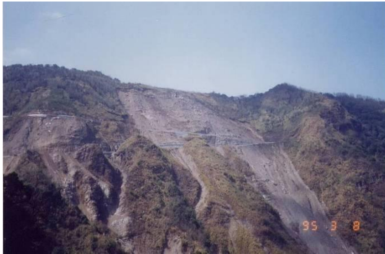
圖 12.38 台 21 線塔塔加鞍部大回頭彎之大規模淺層坍塌
