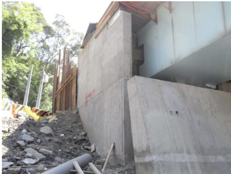
圖 11.21 以混凝土結構保護橋台基礎
