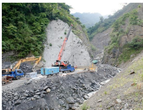
顯見之逆級配堆積或土石流型態
