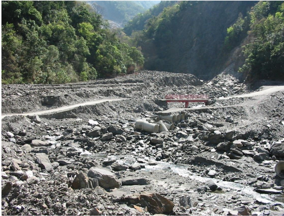
圖 12.53 力行產業道路集水區於暴雨後形成土石流
