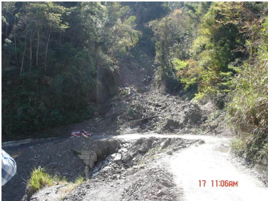
圖 12.30 力行產業道路之上邊坡崩塌與下邊坡向源侵蝕
