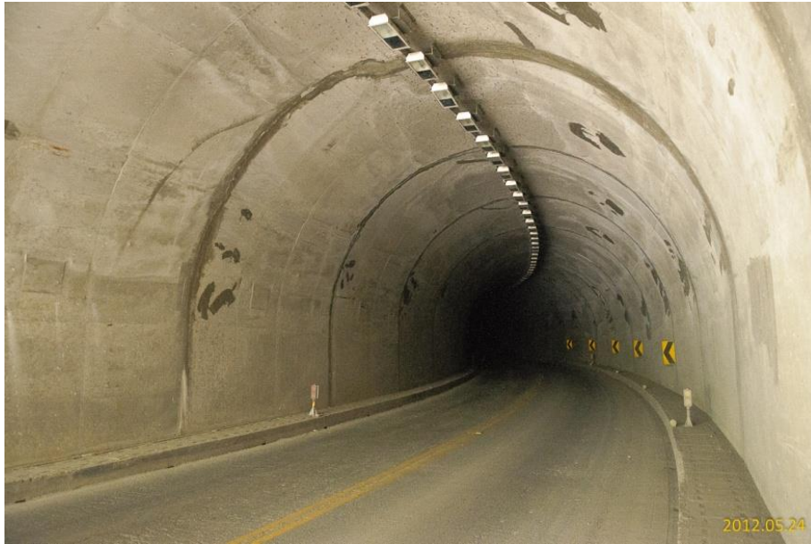
圖 11.14 隧道襯砌現場些微破壞(補丁)徵兆例
