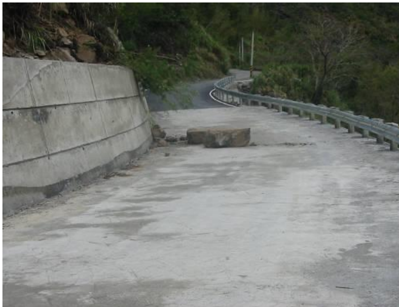
圖 12.57 尖石鄉竹 60-1 扁平石塊掉落
