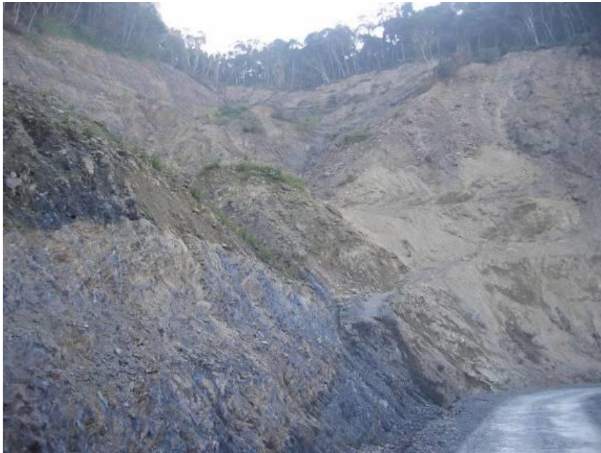
圖 12.24 大鹿林道之沖蝕溝
