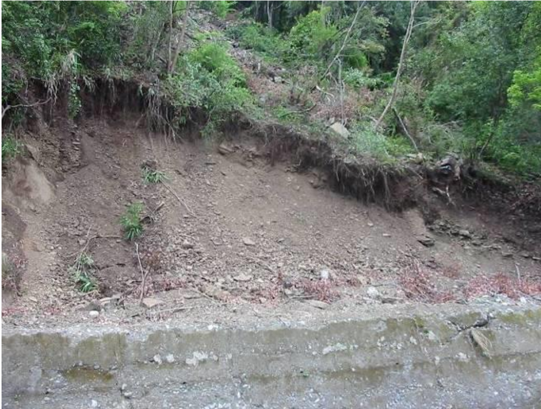
圖 12.40 尖石鄉竹 60-1 上邊坡淺層破壞
