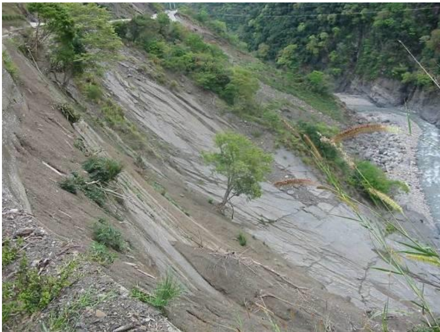
圖 12.47 竹 60-1 線道路下邊坡因凹岸沖刷導致大規模順向坡滑動
