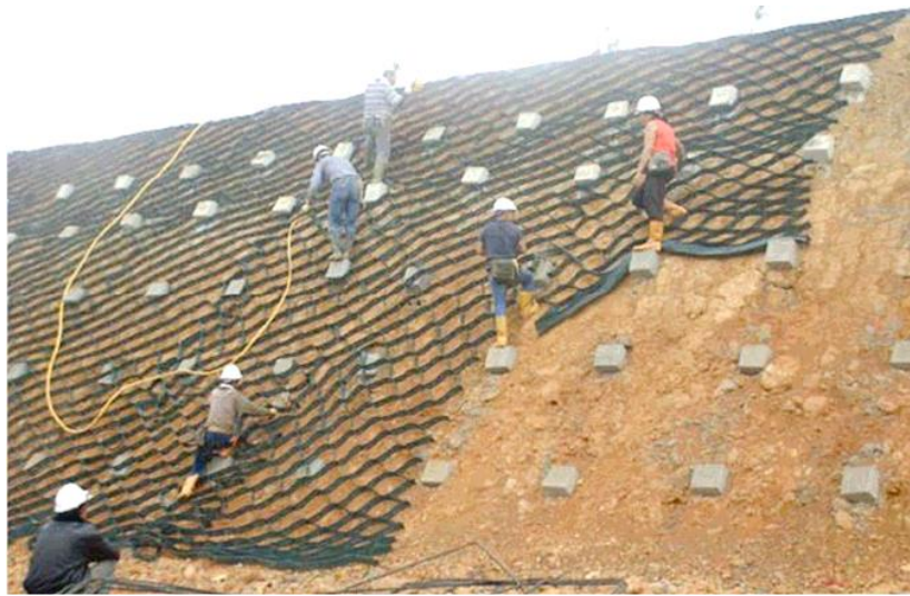
圖 2.10 地工格框進行邊坡坡面防護
