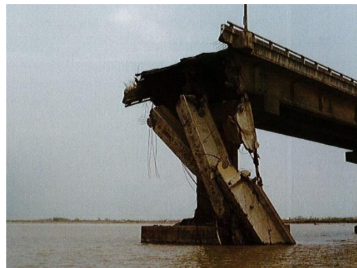
圖 4.14 洪水沖刷導致基礎破壞而塌落
