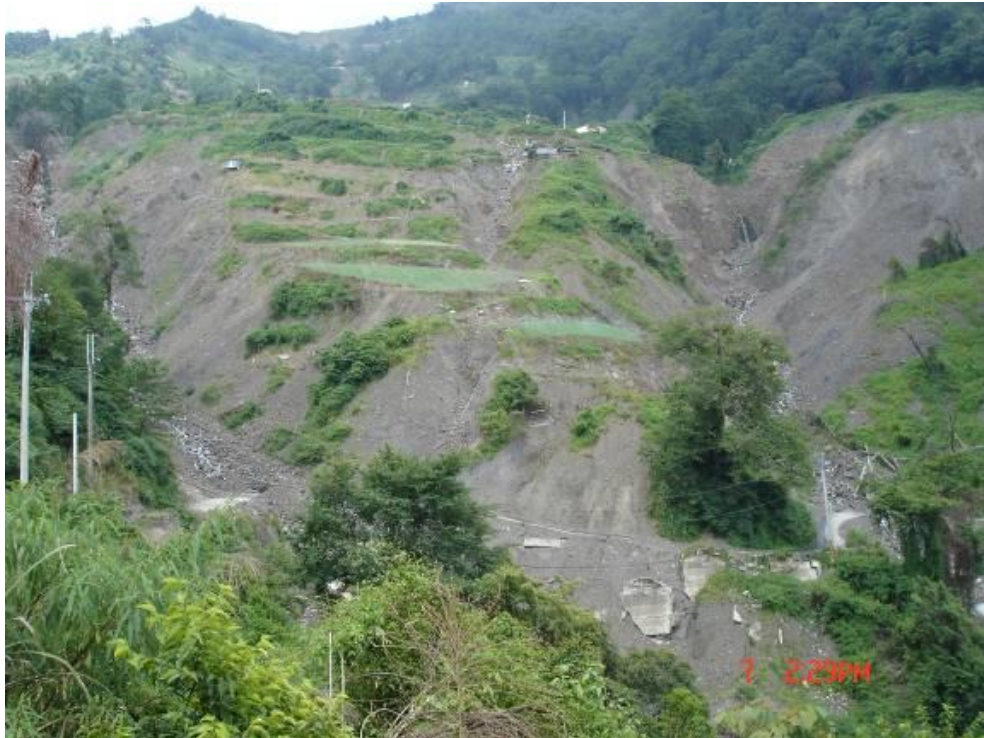
圖 12.54 力行產業道路 34K+200 道路上邊坡左右側土石流
