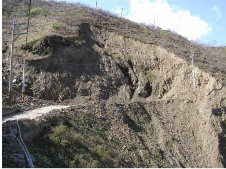
圖 12.42 力行產業道路邊坡圓弧滑動
