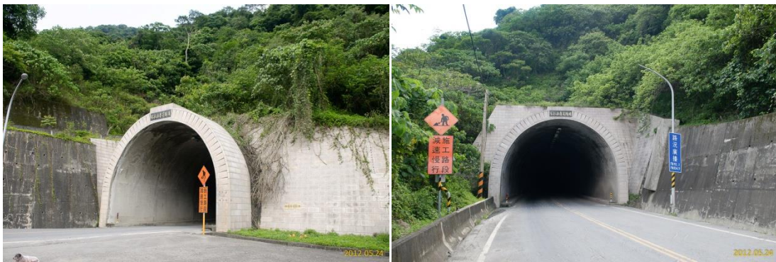
圖 11.12 洞門結構為鋼筋混凝土材料例
