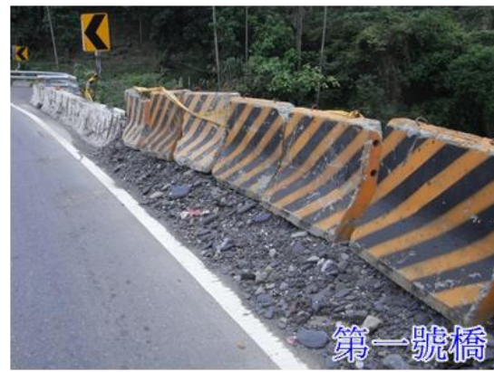
圖 11.25 洪水將橋護欄沖毀
