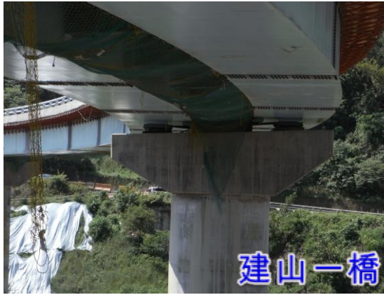
圖 11.26 建山一橋支承現況
