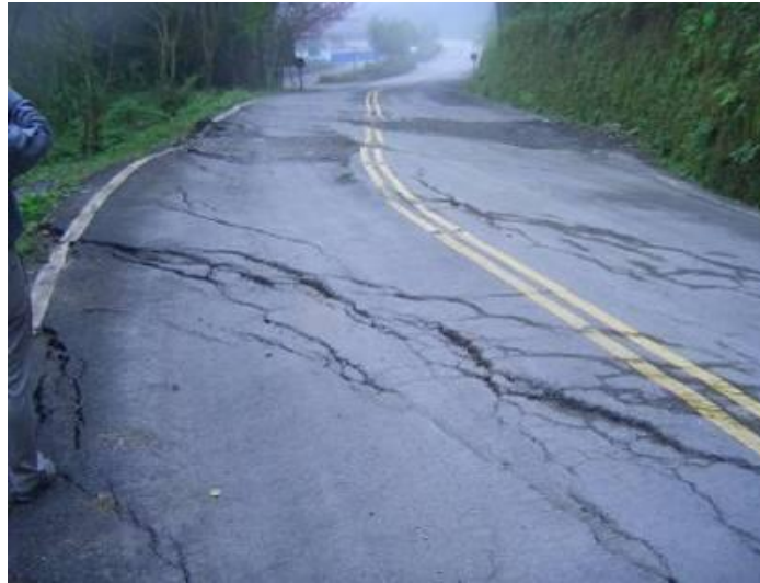
圖 12.17 林務局宜專一線路基因雨水入滲造成滑動
