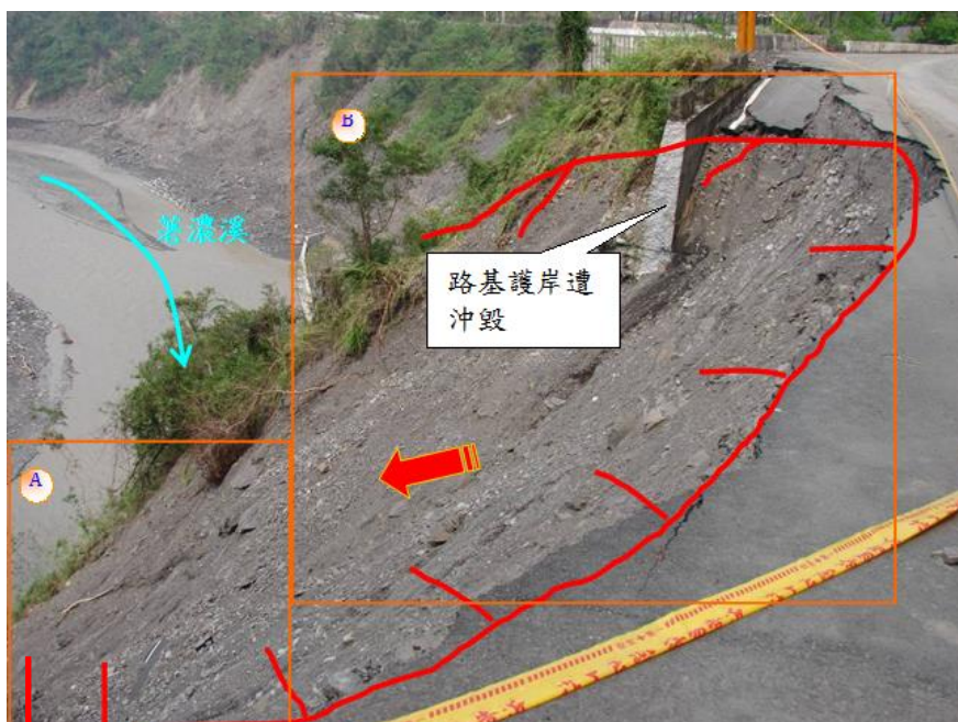
圖 4.19 強降雨→河川、野溪暴洪→路基流失→阻斷道路交通災害鏈
