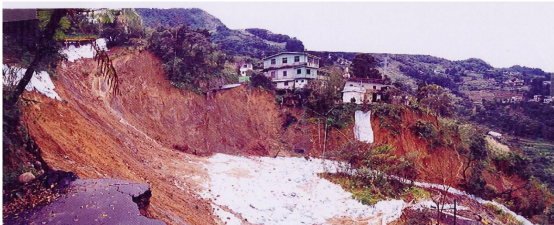
圖 12.45 臺北市文山區指南路 3 段(貓空)近圓弧深層滑動
