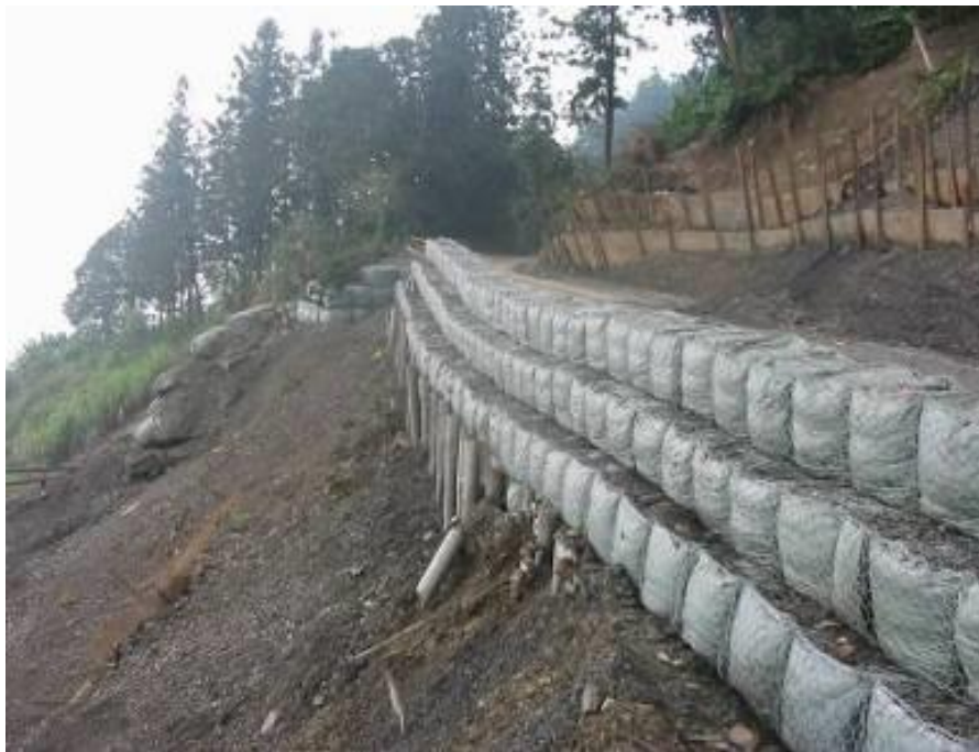
圖 12.18 宜專一線以土石籠及鋼軌樁作為臨時支撐
