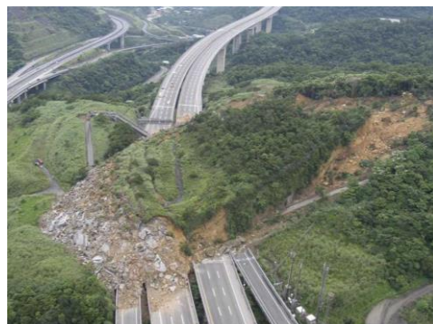
順向坡坡趾出露或坡面有凹陷隆起等破壞徵兆
