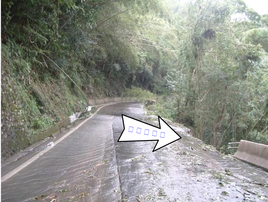
圖 12.14 漫地流造成路基流失實例
