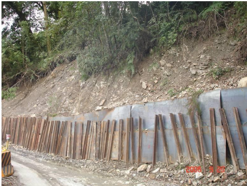
圖 2.4 台 8 線之鋼板排樁
