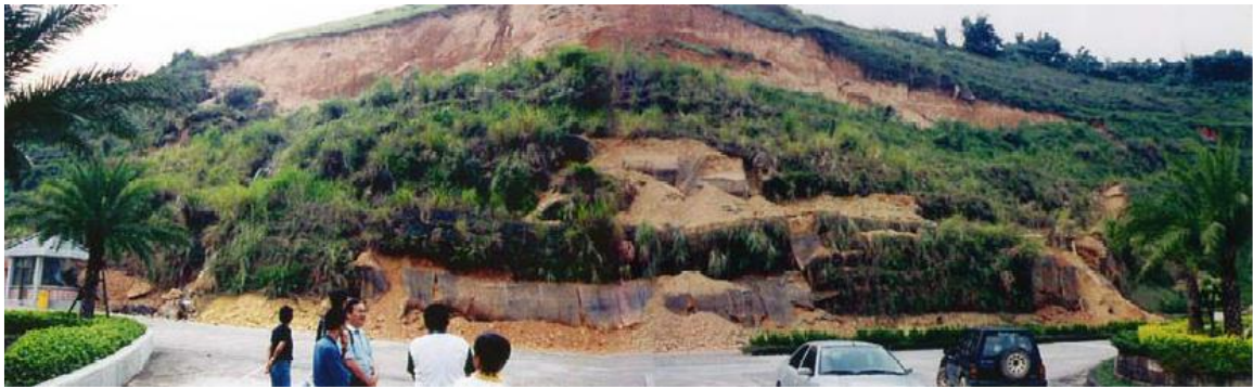
圖 12.49 暨南大學聯絡道於 921 後沿硬黏土層之大規模順向坡滑動
