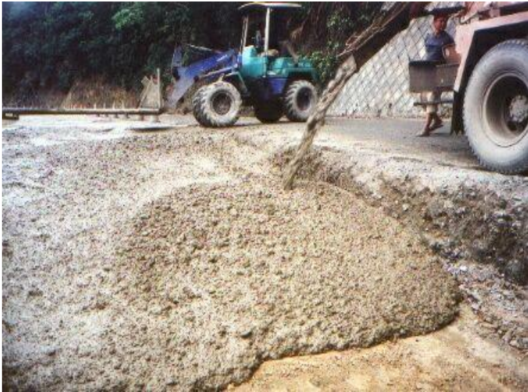
圖 12.12 以開挖棄土拌製 CLSM 填築路基
