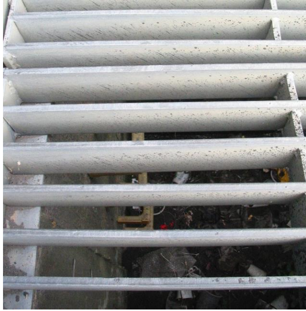
圖 11.11 排水系統輕微阻塞例
