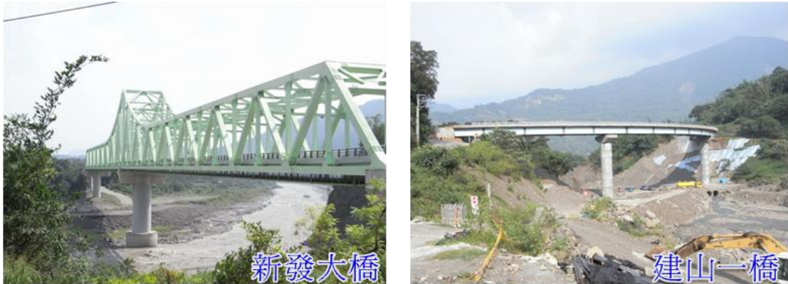
圖 11.17 一向具多柱式橋墩
