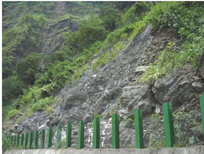
圖 2.3 設置於風化邊坡之防落石網
