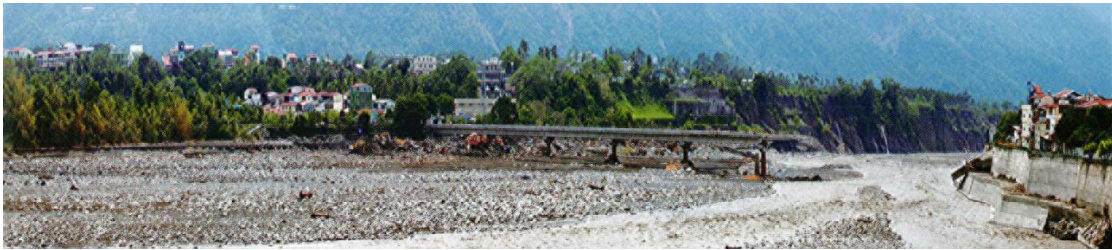
圖 4.13 橋址位於河道彎曲處或洪水攻擊角，導致基礎與護岸掏空，局部橋跨沖毀
