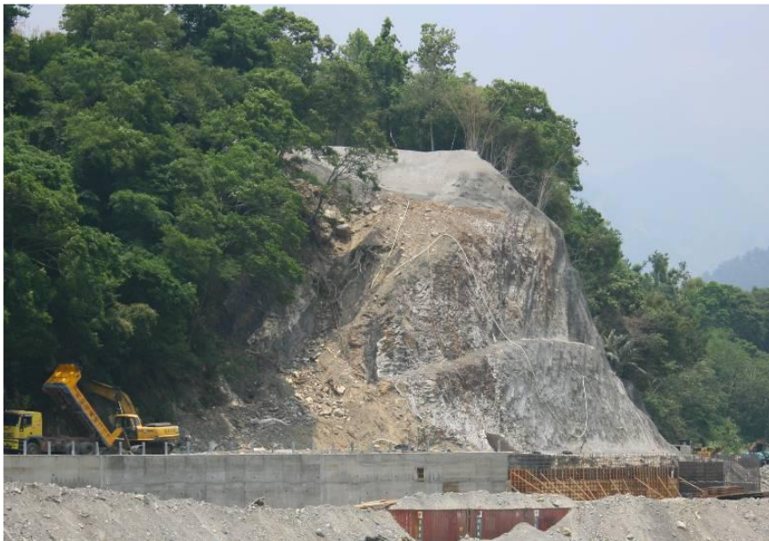
圖 2.9 噴凝土工法用於道路邊坡
