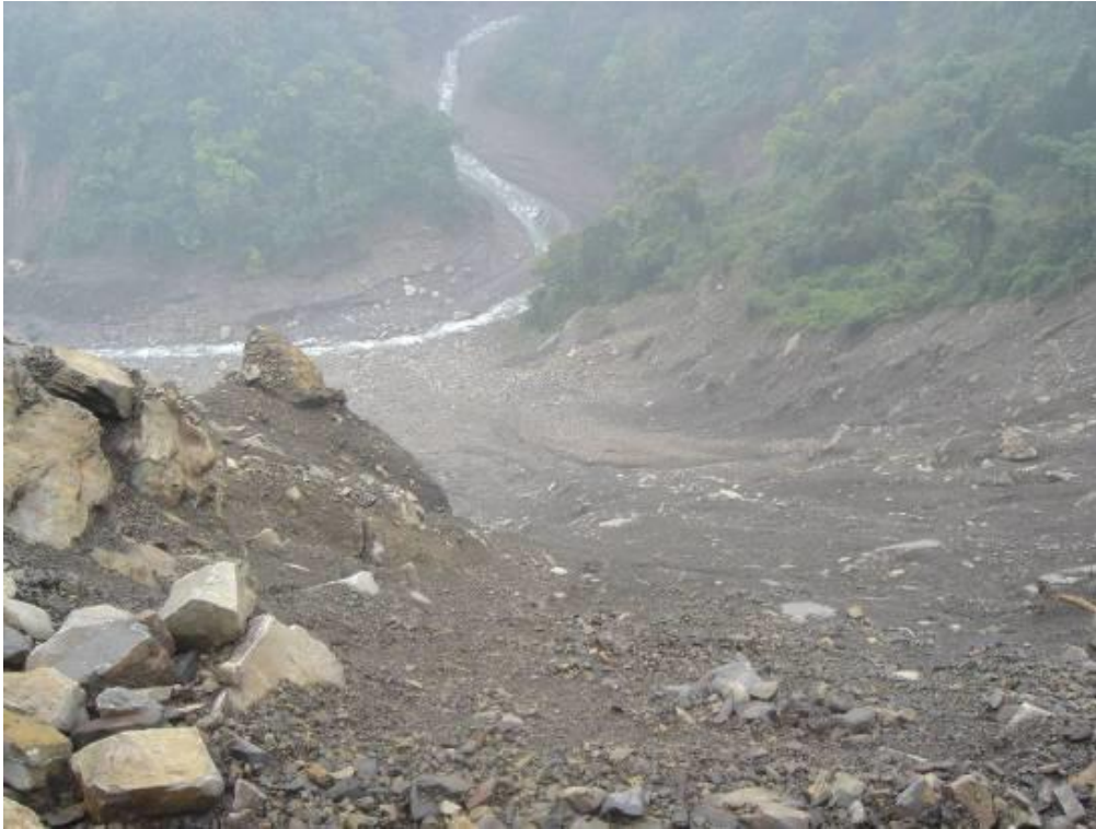
圖 12.33 大鹿林道 2K+700 下邊坡凹岸沖刷
