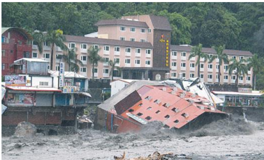
照片來源：2009.08 台東知本溪堤防、護岸潰決、金帥飯店倒塌災害，聯合報。
