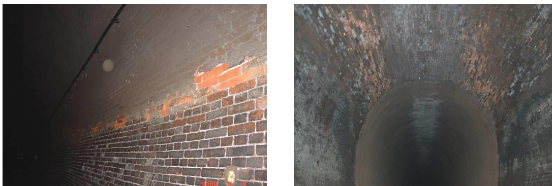
圖 11.13 隧道襯砌採磚造材料例
