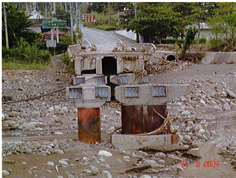
圖 4.9 橋址位處河道窄縮處洪水溢流衝擊導致橋面版傾覆
