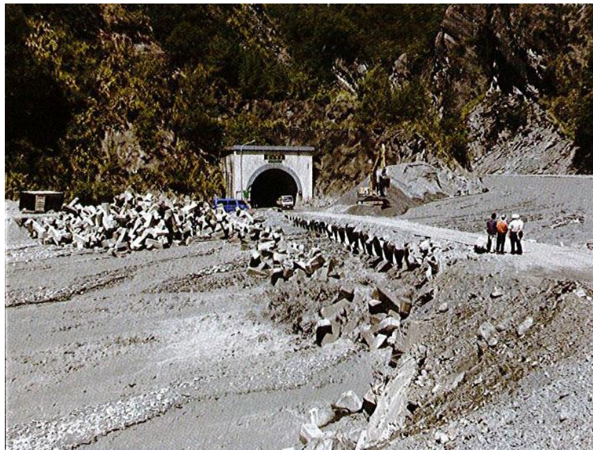
圖 4.11 台 20 線利稻橋河床土近端引道邊坡滑落路基掏空
