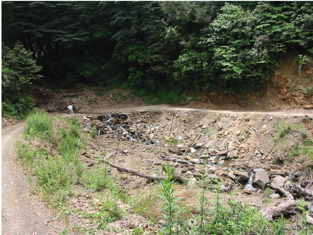
圖 12.28 力行產業道路向源侵蝕形成回頭彎
