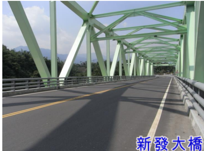
圖 11.28 新發大橋磨耗層狀況良好
