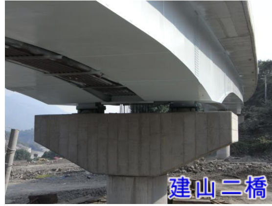
圖 11.27 建山二橋支承現況
