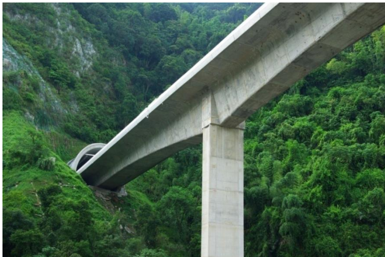
圖 12.7 國道六號埔里隧道西洞口橋隧道交接
