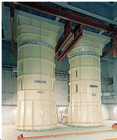
圖 2.1-34 日本東京灣跨海公路海底隧道噴流式排風機與電動除塵器
