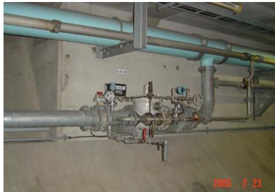
圖 2.1-32 日本東京灣跨海公路海底隧道水噴霧系統節流閥
