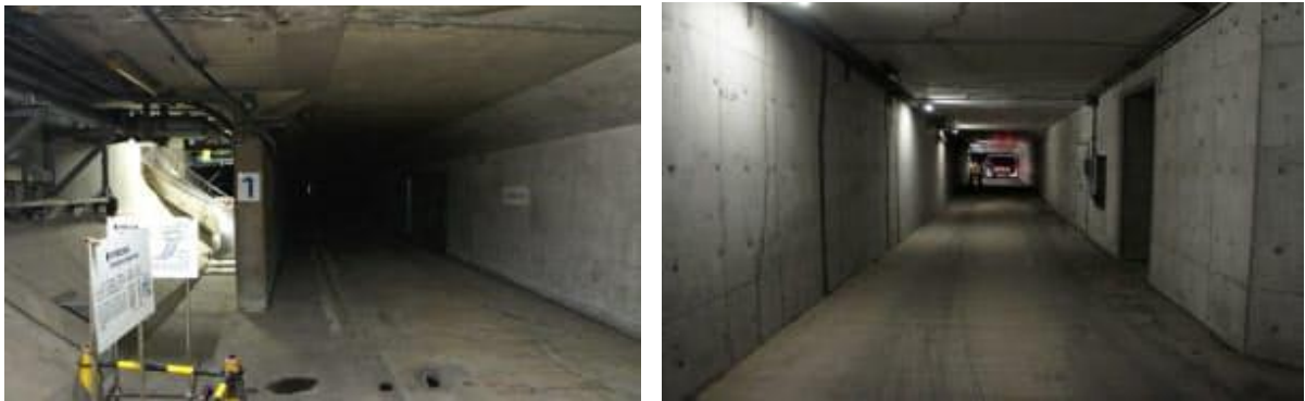
圖 2.1-31 東京灣跨海公路海底隧道緊急避難逃生滑梯與維護管理專用道路
