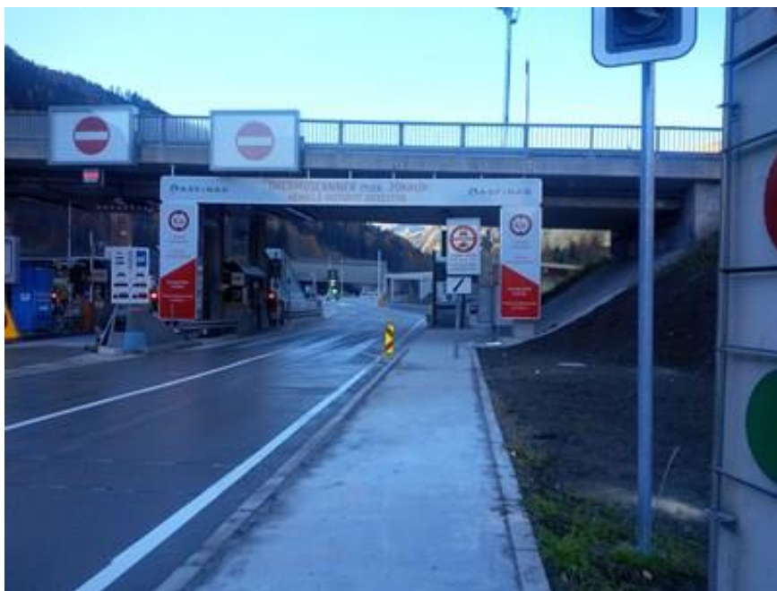
圖 2.1-15 奧地利阿爾貝格公路隧道熱掃描儀器
