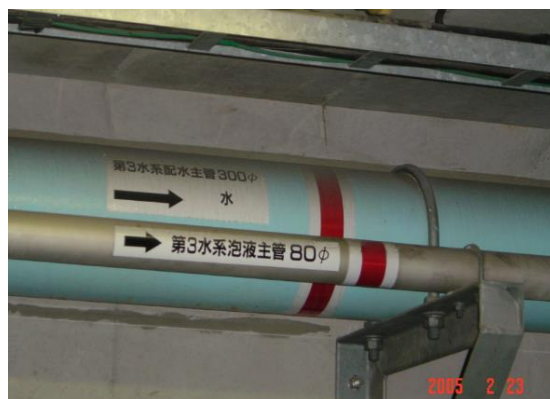
圖 2.1-33 日本東京灣跨海公路海底隧道水噴霧系統配水、泡沫管
