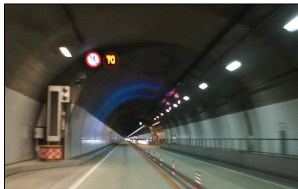
圖 2.1-24 日本飛驒隧道重點照明
