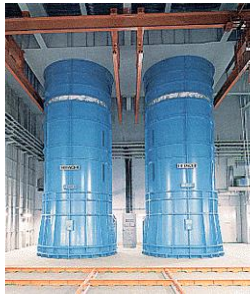
圖 2.1-34 日本東京灣跨海公路海底隧道噴流式排風機與電動除塵器
