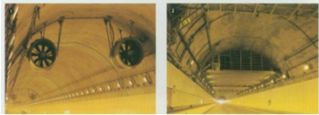
圖 2.1-34 日本東京灣跨海公路海底隧道噴流式排風機與電動除塵器
