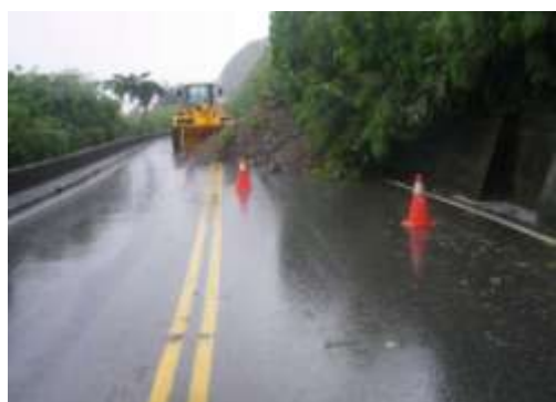
施工大型車輛
