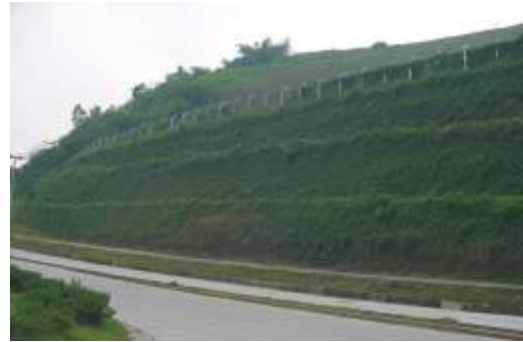
圖 4.1-16 加勁路堤邊坡型式
