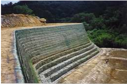
圖 4.1-16 加勁路堤邊坡型式
