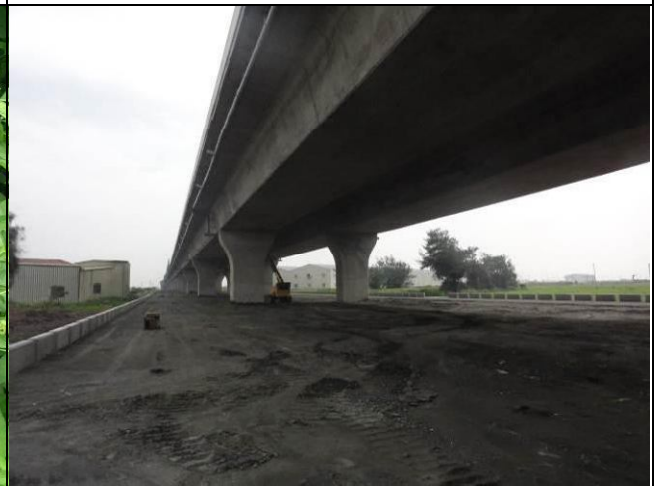
施工區域環境照
