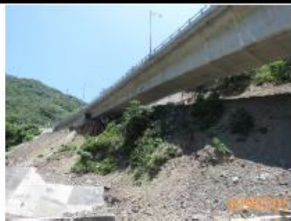
台九線下邊坡植被
