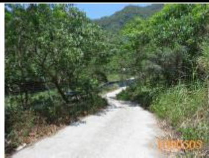
既有道路做施工便道使用
