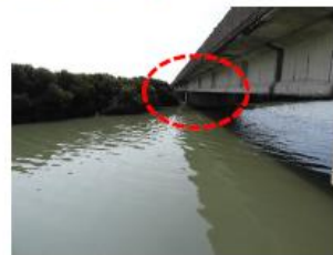
東勢南橋橋墩旁紅樹林 108.11.11
