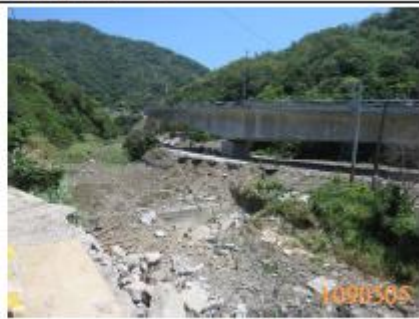
工區內楓港溪溪況
