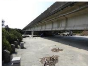
物料堆置區使用既有裸露區域 108.11.11
