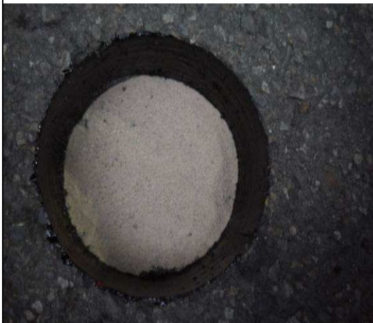
A 法. 孔底鋪清砂整平
