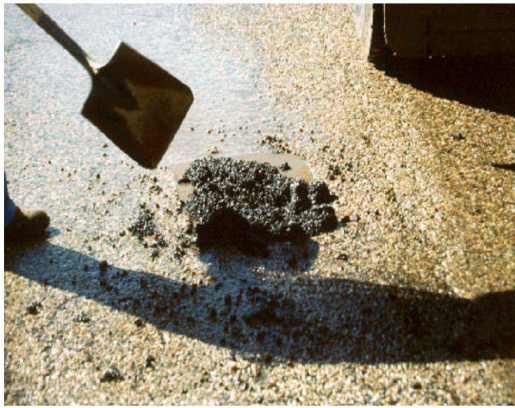
圖 3. 修補材料置入坑洞
