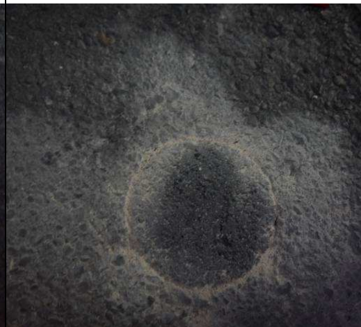
A 法. 瀝青磚安裝完成
