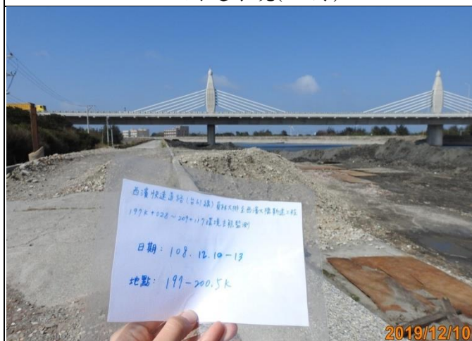
工區周邊環境(12月)
