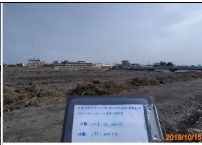
工區周邊環境(10月)
