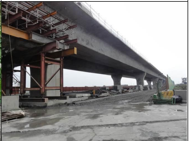
施工區域環境照
