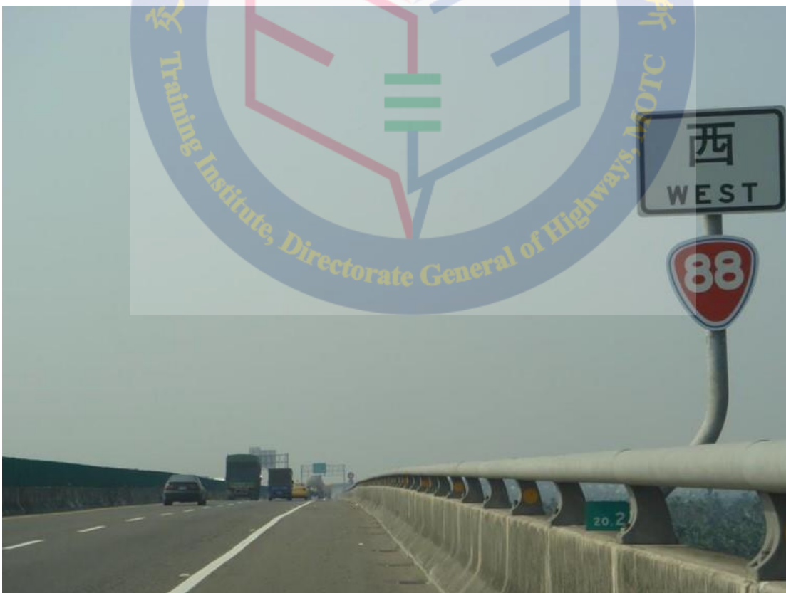
圖八 快速公路方位及編號指示標誌
