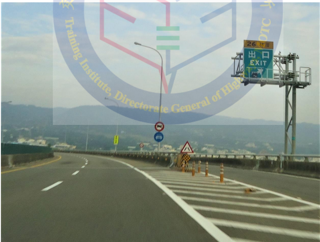
圖 十二 台 76 線快速公路八卦山隧道禁止大型重型機車進入 - 4
