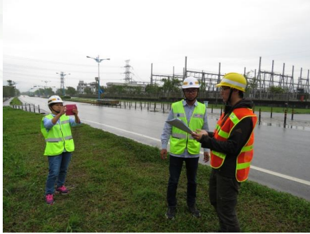
施工與生態 人員現勘
