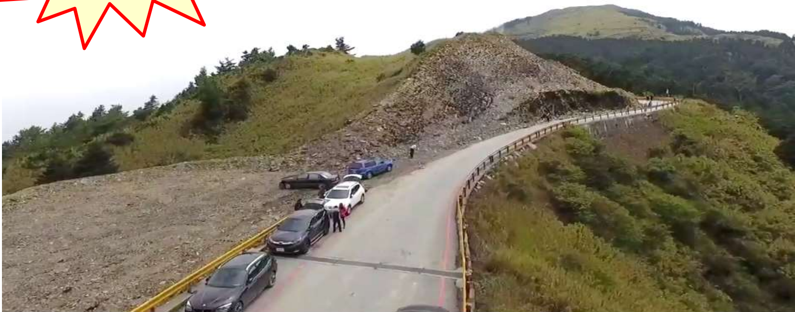
台14甲線37k處目前進行邊坡刷坡工地現況
