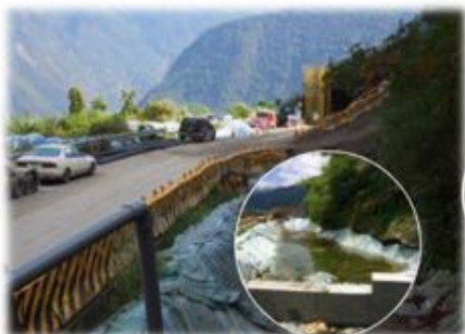
122k+600 沉砂池(施工期間)
