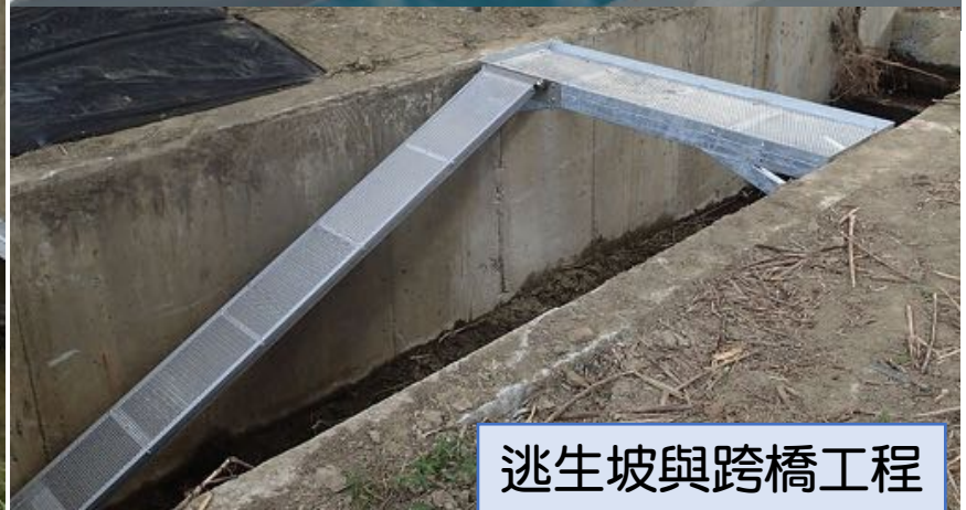
排水溝跨橋結構
