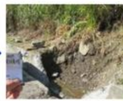
124k+800 生物坡道
