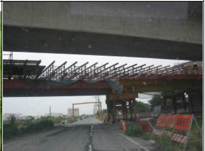
施工區域環境照
