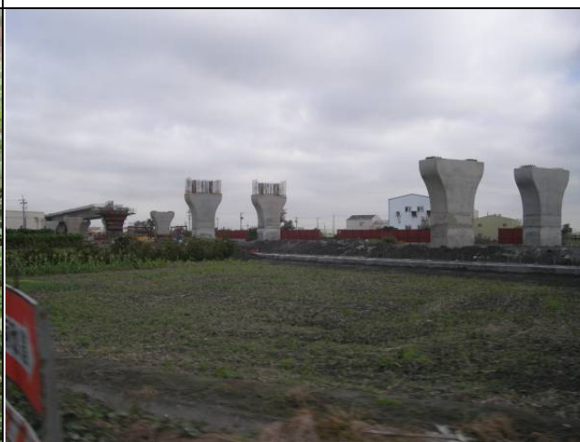
施工區域環境照
