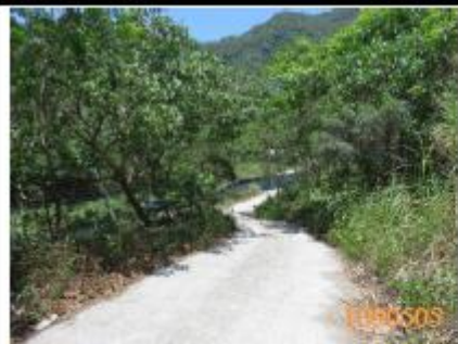
既有道路做施工便道使用
