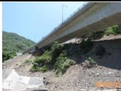
台九線下邊坡植被
