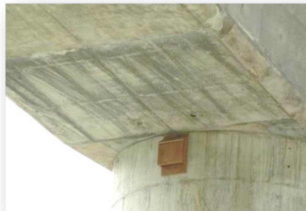
台9線蘇花改設置 鳥槽箱作為生態棲所
