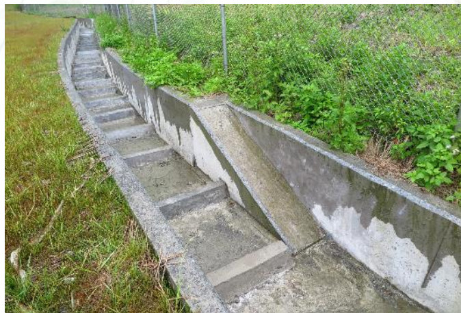
台9線蘇花改排水溝 設置動物坡道
