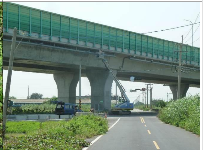
施工區域環境照
