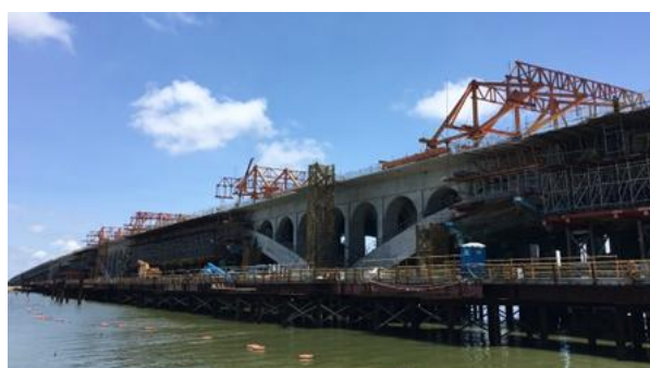
B 標- U15S 上構箱型梁施工
