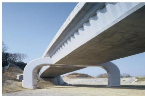
圖 5.1.3-4 波形鋼腹板設計及應用
