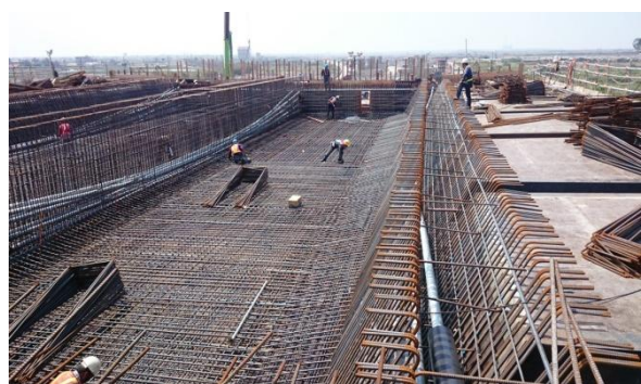
C 標-上構橋單元底腹板施工
