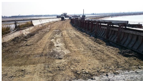
A 標-加勁路堤與進橋版施工
