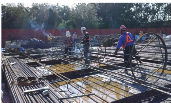
B 標-基樁鋼筋場作業
