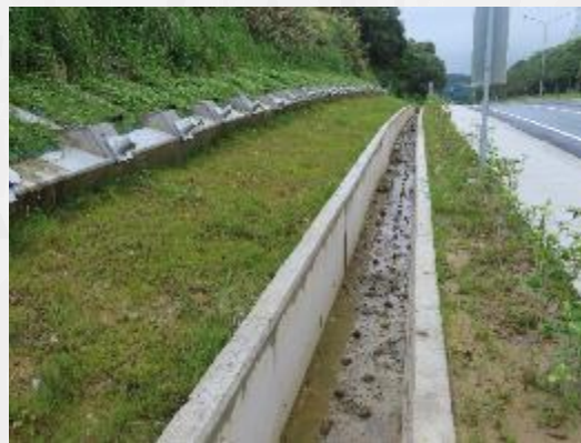
新設U型明溝
