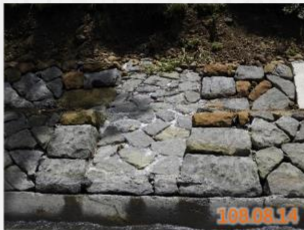
設置動物通道
