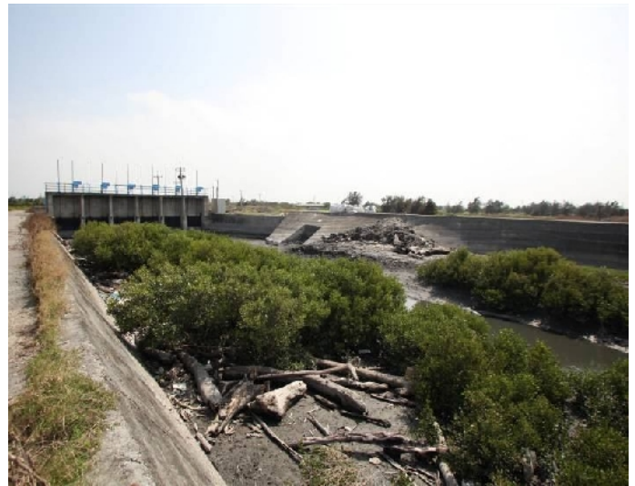
2.溝渠(A2) 99.10.05攝於計畫道路203.8k處
