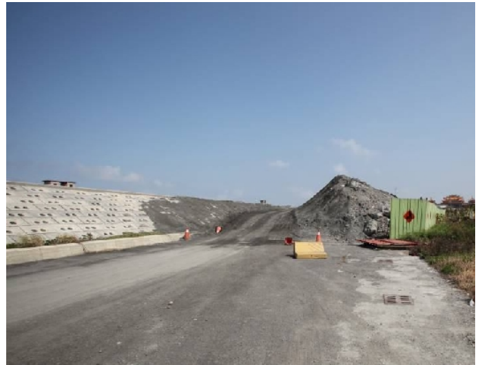
16.施工中的抽水站(H1) 99.10.14攝於計畫道路02.2k處
