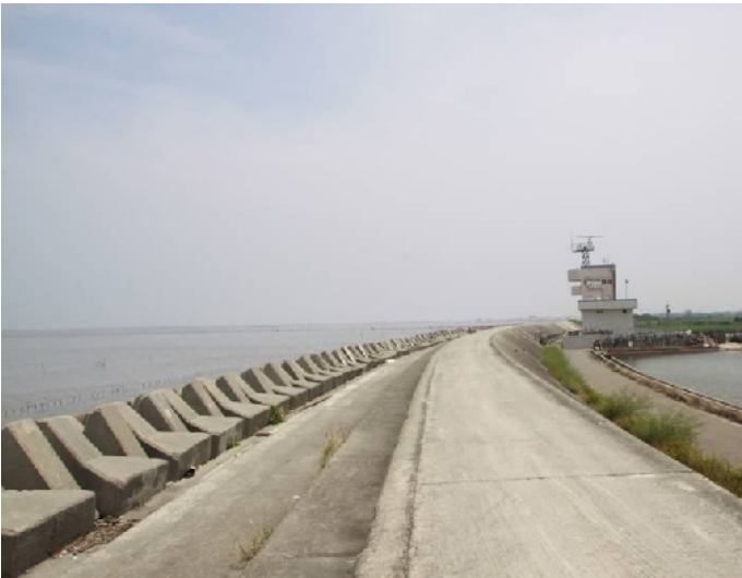
15.海堤(H3) 99.08.17攝於計畫道路205.5k處
