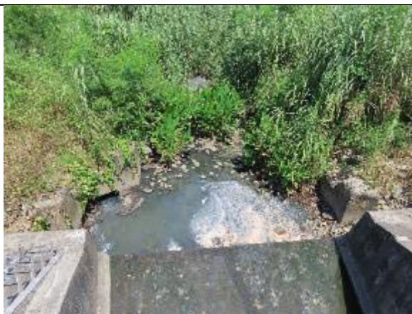
排水溝 (注入旗山溪支流)
