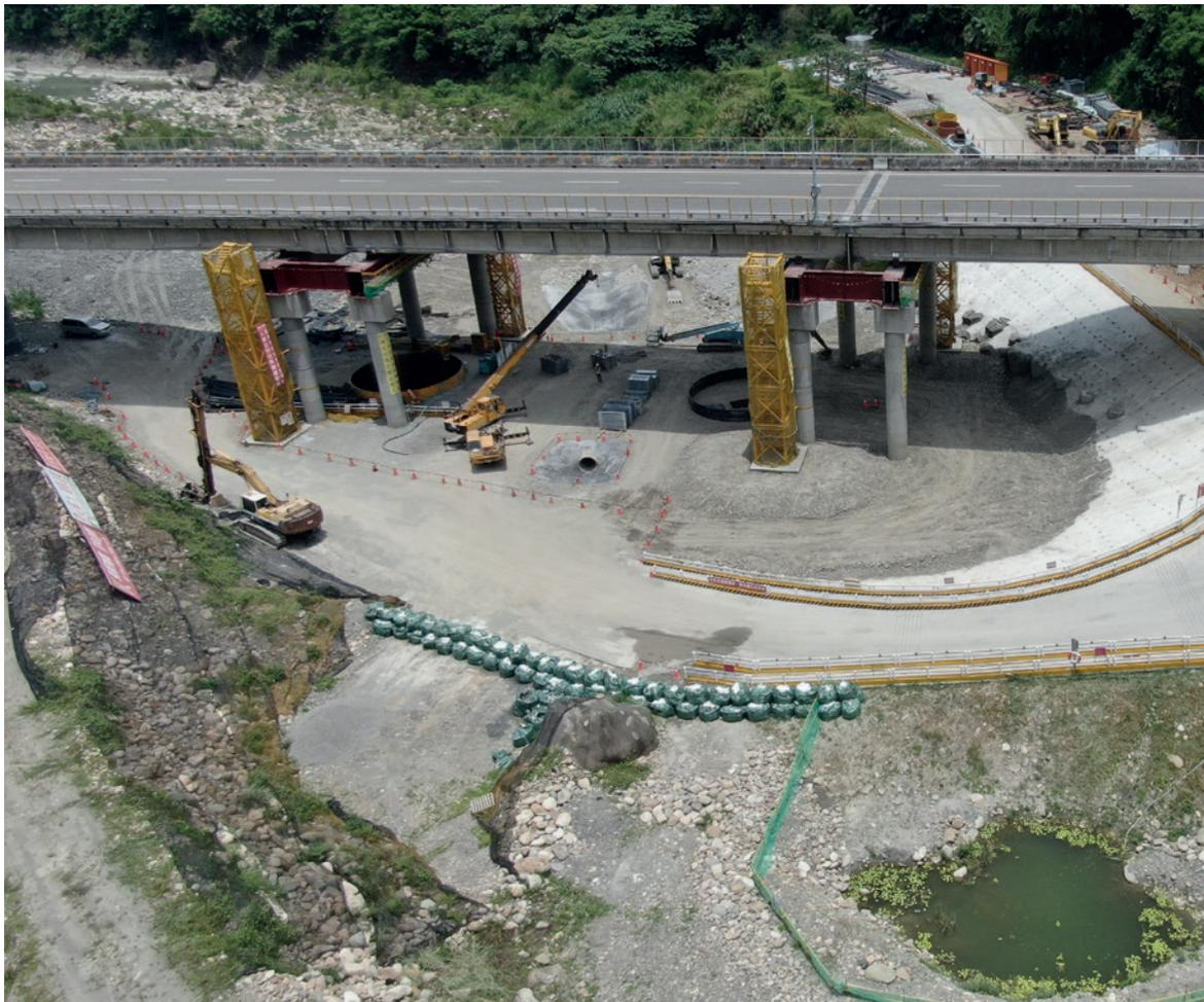
育樂橋P4至P6橋基改建工程施工照片。
