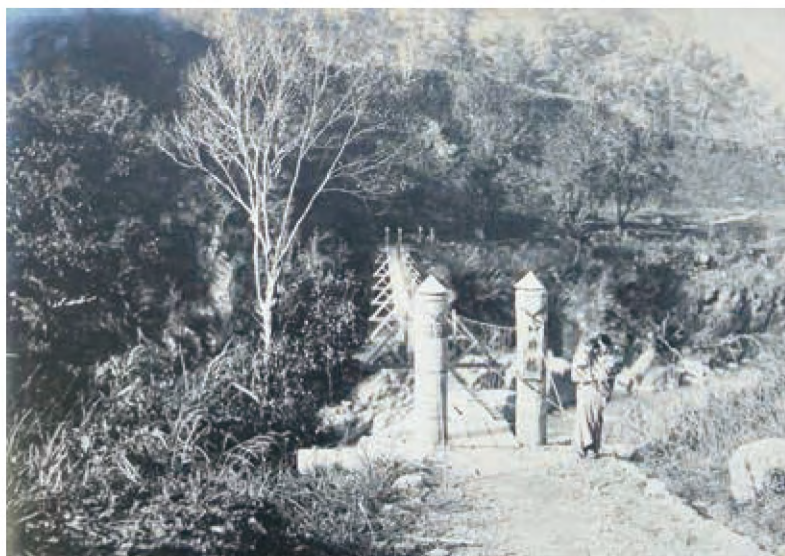
山腳橋是久良栖(今松鶴)跨越大甲溪的唯一橋梁，這4張照片攝於大甲溪道路(自久良栖，經明治溫泉(今谷關)、沙拉茂(今梨山)，抵志佳陽(今環山))剛剛完成時，1923年。山腳橋橋頭書寫總長八十尺(24M)，大正十二年(1923)一月竣工。
