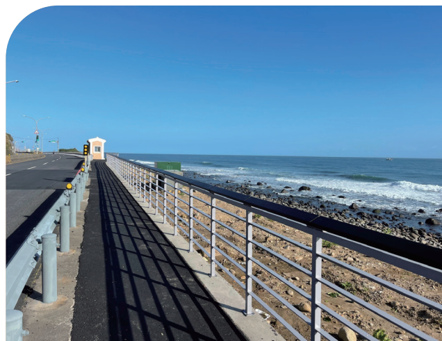
變電箱遷移及候車亭外繞
