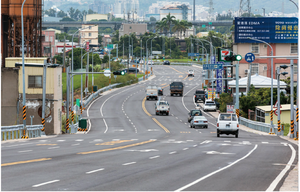
台 13 甲線為聯絡頭份、竹南、造橋、後龍及苗栗市五個鄉鎮市的南北縱貫交通要道，沿途蜿蜒多彎。
