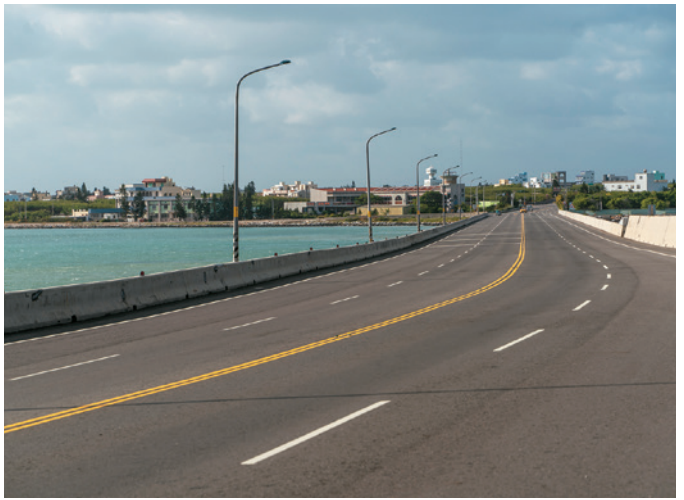
縣道 203 線自馬公市出發，通往西嶼鄉，全線串聯澎湖三座跨海橋梁、四座島嶼。
