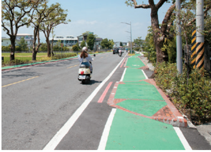
宜 17 線人行道以冷塑型止滑塗料鋪面。
