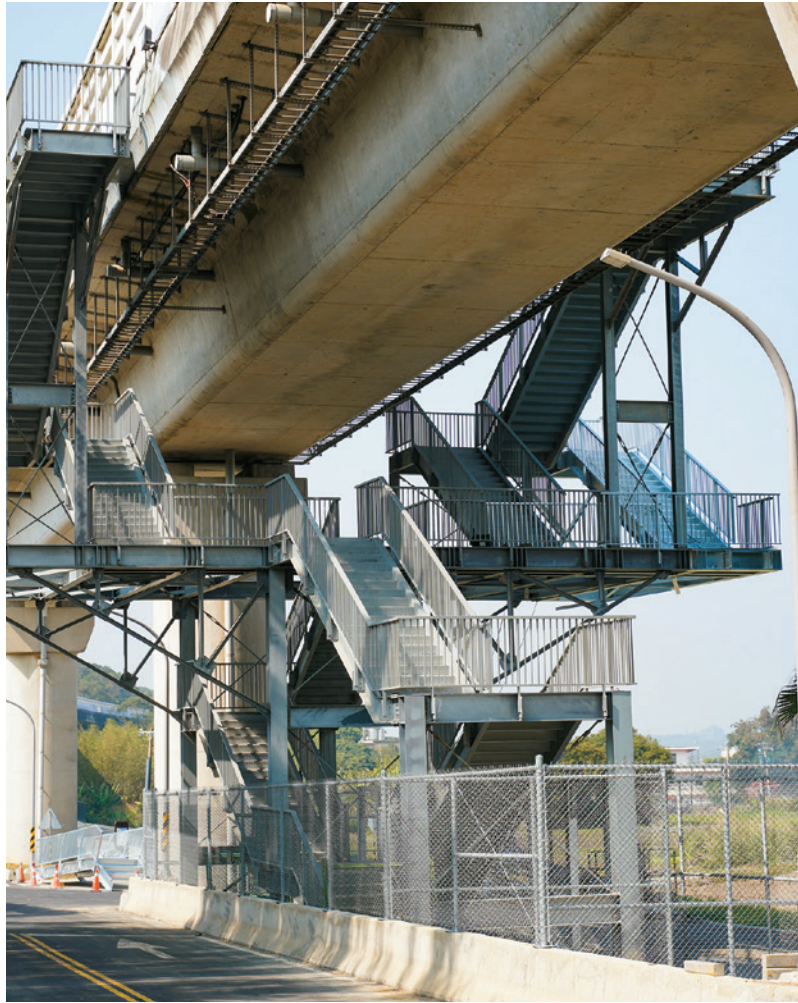
為保障民眾與行車安全，工程也重新設計 Y 字結構的桃捷逃生梯，將落地處集中在中島以避開車道。
