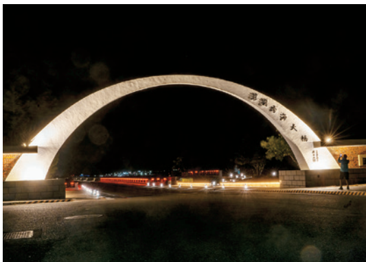
夜間的跨海大橋重新以線性光雕設計裝飾橋身，成為夜間遊覽新亮點。
