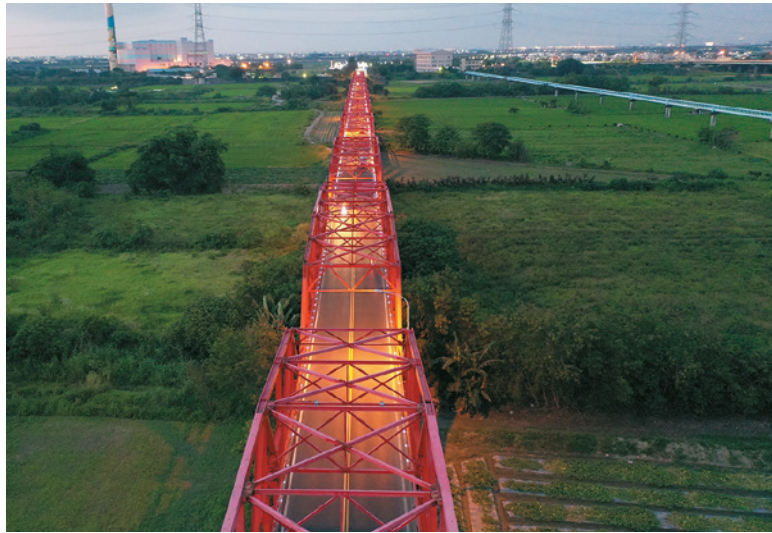
加裝 LED 警示燈之後，現在西螺大橋的夜間照明好很多。
