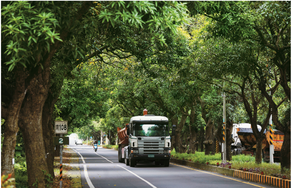
南108線施作國內罕見的剛性路基，強度可以承受坦克車重量的輾壓。
