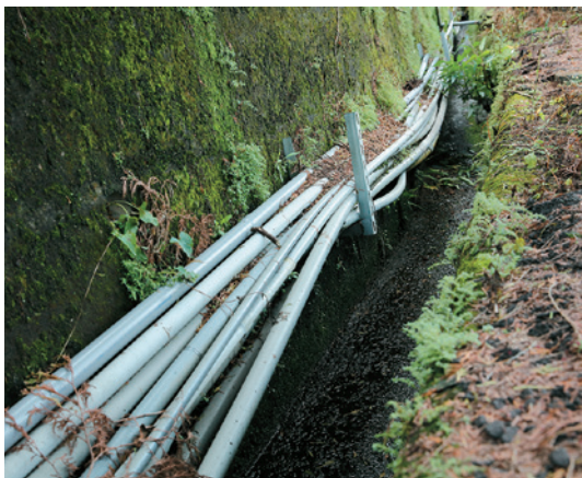
將原本山坡排水溝底的管線架高，可避免沉積落葉砂土，雨天排水更通暢。
