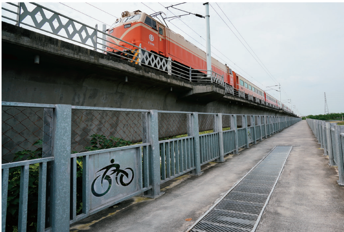
高雄—屏東潮州高架鐵路通車後，下方規劃為單車鐵道，吸引許多車友，部分路段還能與火車伴行。
