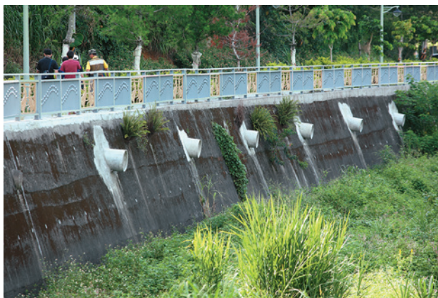
增設排水管，讓雨水滲透人行道鋪面後可迅速從大排水溝排出，避免積水。
