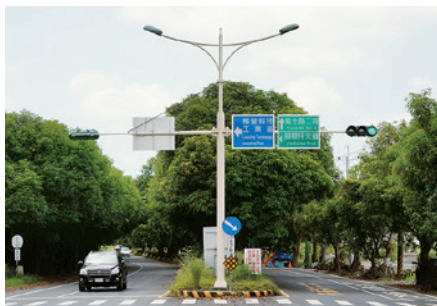
南 108 線將以往紊亂的路牌、路燈與號誌燈，重新以共桿方式整頓。
