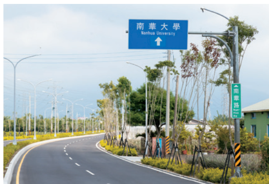
南華路是 162 乙線重要支線，通往南華大學，本次路口兩側進行綠帶施作。
