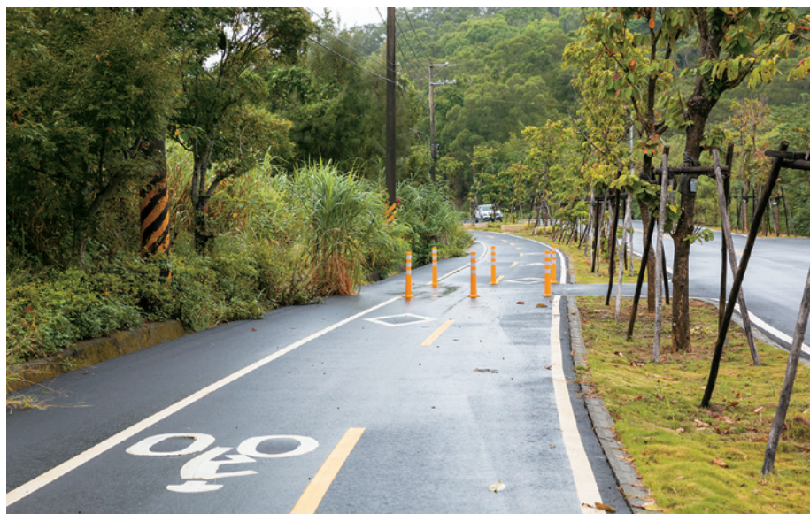
台 13 甲舊路段整建後將人行道、自行車道、汽車道以行道樹綠帶分隔，兼具綠美化與人車安全效益。
