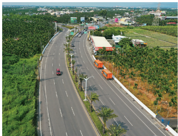
屏 85 及屏 75 線道路景觀改善，包括管線地下化、路燈號誌共桿、標線標誌整合改善等，打造出南島綠廊意象。
