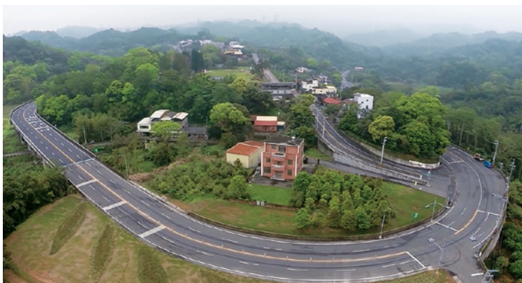
台3線苗栗段鋪面使用了鋼鐵業副料轉爐石，更耐重防滑。圖中的三灣路段更獲選為「台灣十大最美景觀公路」之一。
