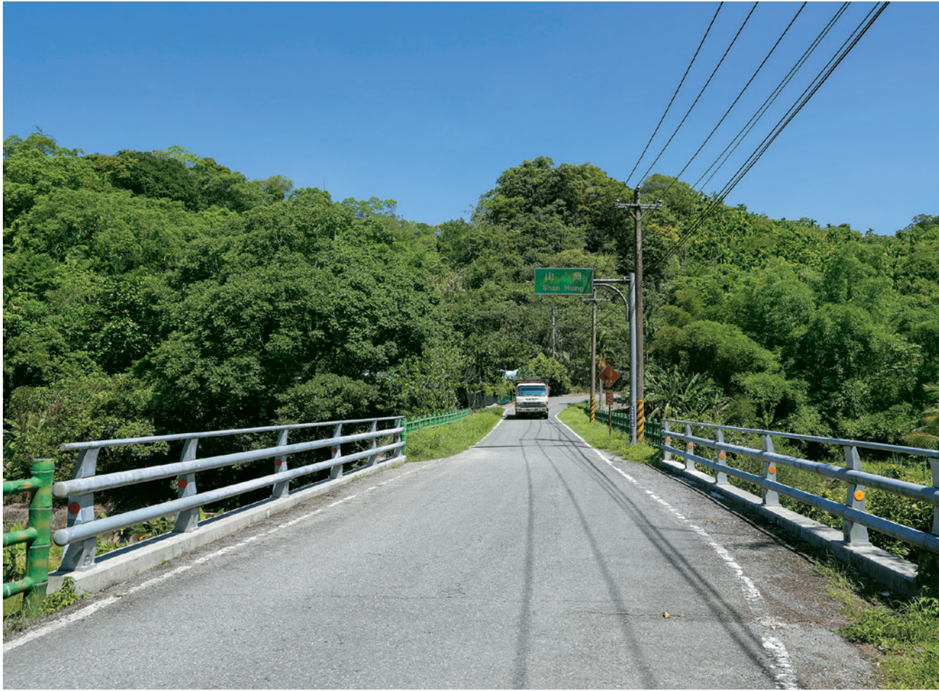
193 線前半段道路改善著重基礎設置，如山興部落附近道路紐澤西護欄改為透空形式，提升行車安全與視野。
