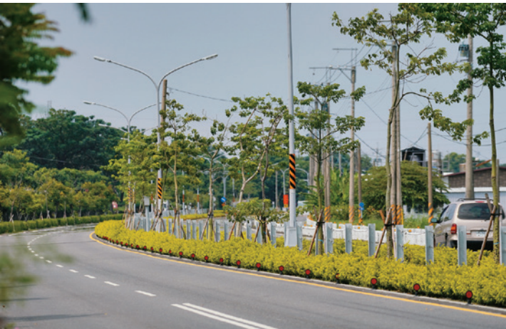
189 甲線為讓道路設施輕量化，將中央分隔島改為以鋼索護欄結合草溝綠帶。
