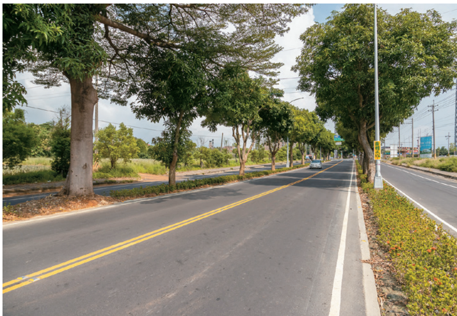
嘉 106 線因機慢車道與快車道之間設有分隔島，機慢車道又過窄而容易側撞導致車禍。 （圖為大學路一段，尚維持原道路分隔設計）
