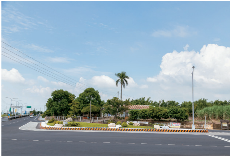
大民南路與大學路交叉路口因過於寬闊，新設實體中央分向島以有效引導車流、改善動線。
