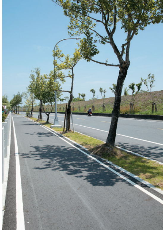
宜 18-2 線重劃自行車道，並於堤岸側加設護欄防墜；而下凹式綠地可有效收納孔蓋與電箱。
