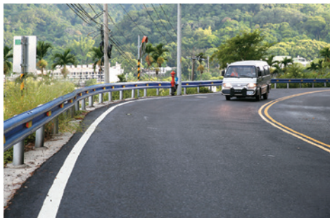
將老舊護欄更換為反光式鋼板護欄，並刨除舊路面以再生瀝青混凝土重鋪，提升山區行車安全。
