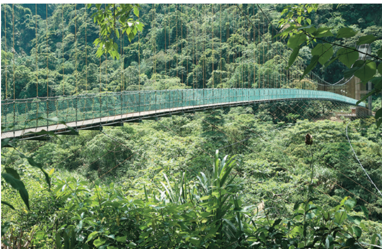
橫跨加走寮溪的瑞龍吊橋。
