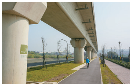
桃捷橋下道路除了增加休閒功能，安全與防震更是工程的一大重點。
