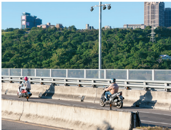
武嶺橋面護欄換裝為透明式擋風牆，可降低陣風影響、維持行車視野通透。
