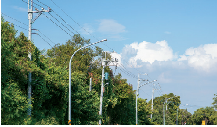
經過艱難的遷桿工程，22 根中華電信電桿終於可以跟路燈整齊排成一列。
