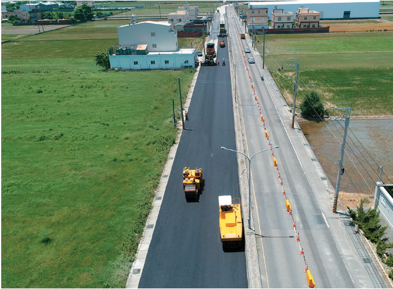
施工時需調撥車道，採半半施工。
