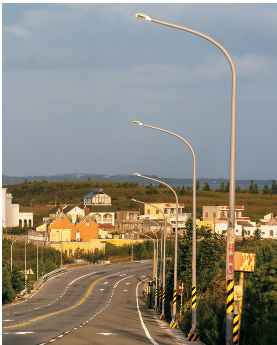
路燈汰換工程將路燈間距自原本每 50 米一盞，調整為每 33 米一盞。
