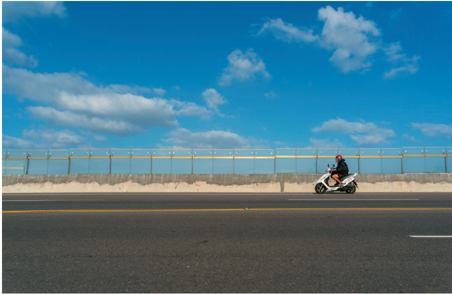
中正橋防浪牆改為強化玻璃材質，將過去被遮蔽的海景視線，還予用路人。
