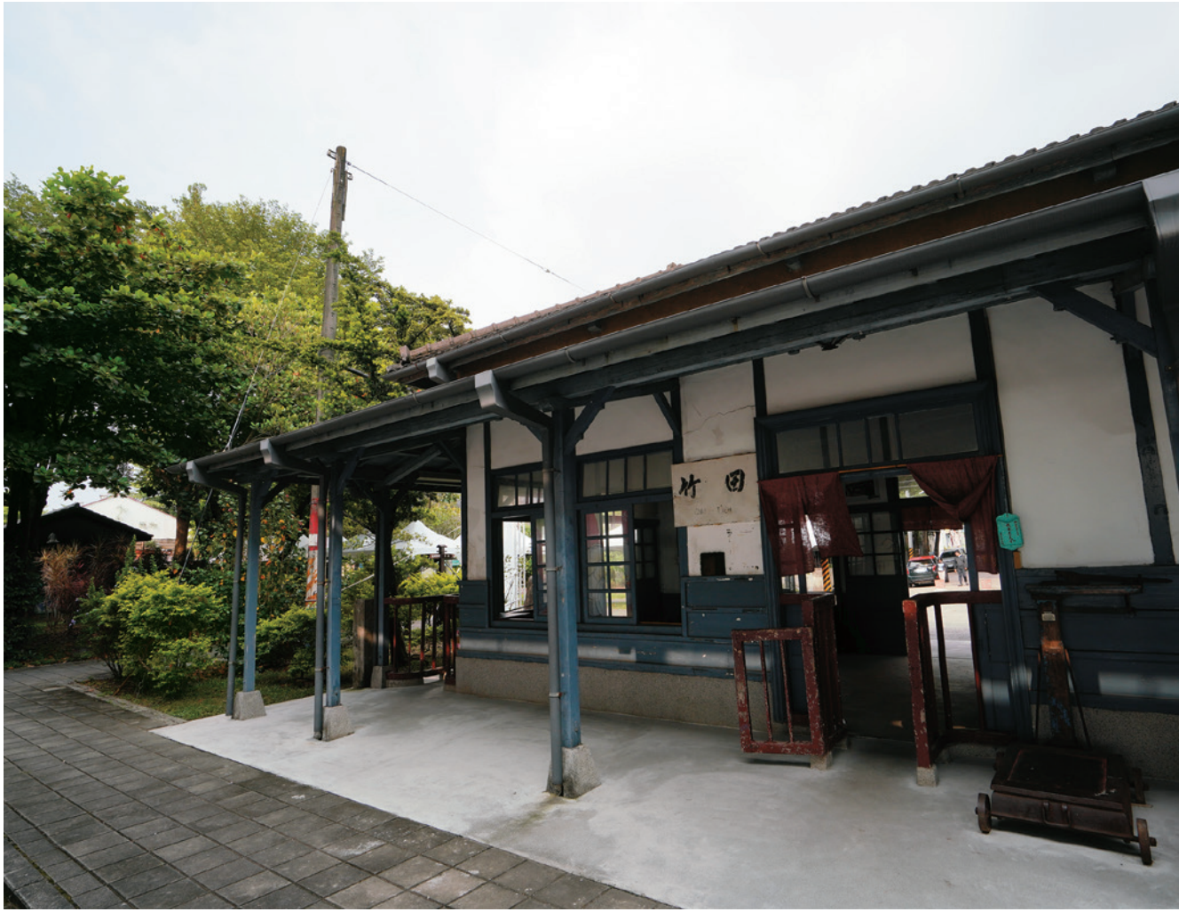
屏東竹田是個純樸的客家聚落，竹田車站興建於 1940 年，是臺鐵屏東線唯一保留的日式木造車站。
