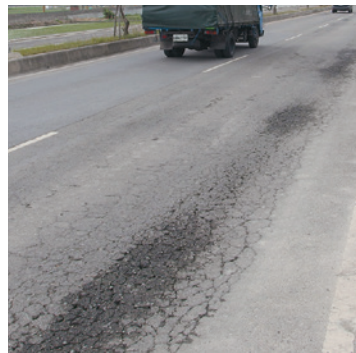
彰化縣政府工務處處長林漢斌說明，彰 206 線先天地下水位高、後天道路地基又沒做好，導致路面嚴重下陷龜裂。
