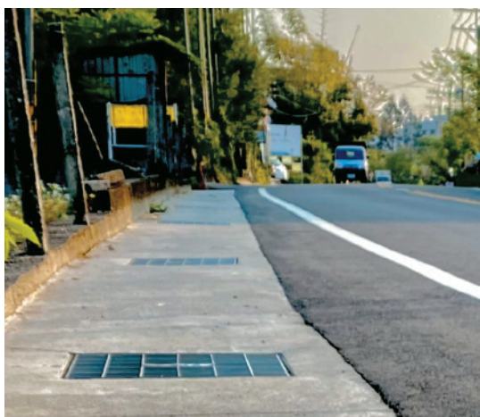
周邊道路刨除後再鋪築，將水溝蓋拉至與地面齊平。
