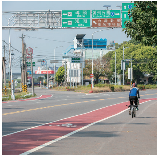
西螺大橋有自行車環島 1 號線經過，重鋪路面時以冷塑標線劃出自行車道。
