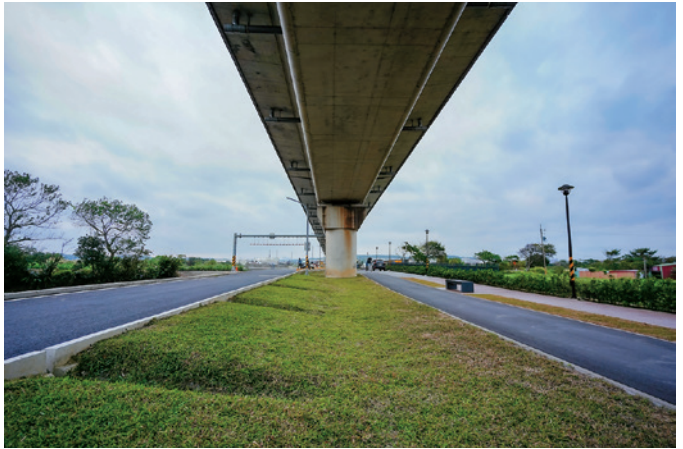
工程團隊將原本往道路兩側的逕流水，改為導入道路中央的綠化區域，並透過入滲方式讓污水淨化。
