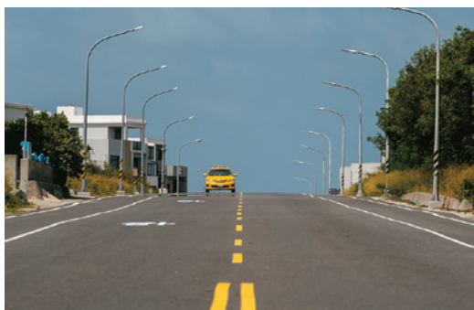
澎 13 線作為機場聯絡道路車流頻繁，路面補釘嚴重，這次終於從路基徹底改善。
