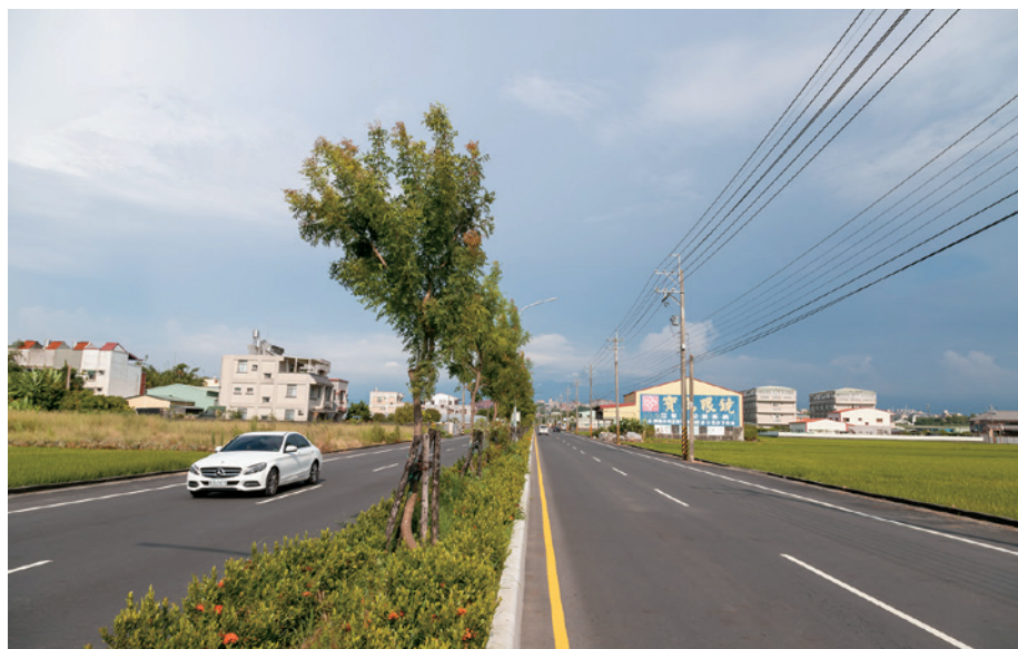
完成道路改善工程後的大學路二段，設置中央單一安全島，道路寬廣而筆直。
