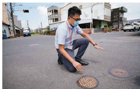
臺南市政府工務局養護工程科黃郁誠股長說明孔蓋下地及調整齊平的作法。
