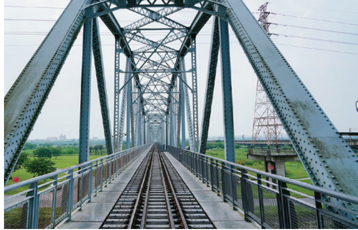
高屏溪舊鐵橋是由日籍工程師飯田豐二設計興建，橫互溪流上的舊鐵橋向來是高屏溪上最美麗的風景。
