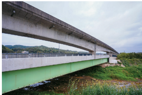
新建橋梁以銜接坑子溪的彎曲路段。
