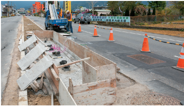
把路燈桿、標誌號誌桿與電箱通通收納進中央分隔島，道路視覺頓時清爽了。
