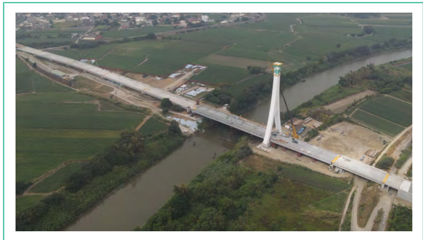
嘉義生活圈縣道157線蒜頭大橋施工空拍全景
