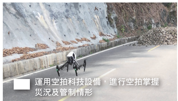
災害現場動員機具進行搶通
