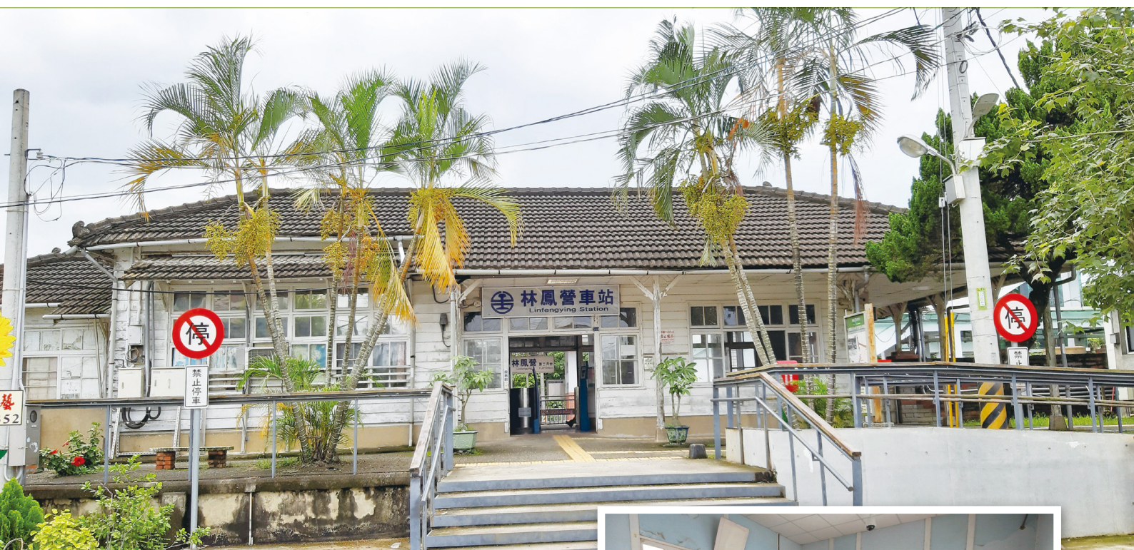
林鳳營車站是純白的日式木造車站，主支撐是用檜木構成「Y」字形支柱。（圖片來源：陳啟榮攝）
