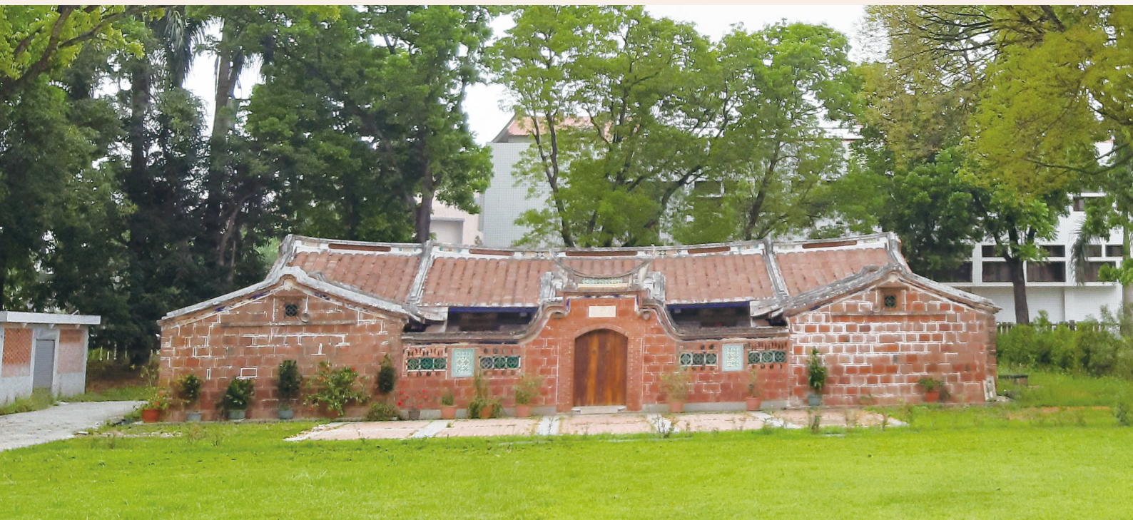
陳家古厝，又稱「居廣居」，因白河大地震導致正身後牆倒塌，現狀為修復後之樣貌。（圖片來源：陳啟榮攝）
