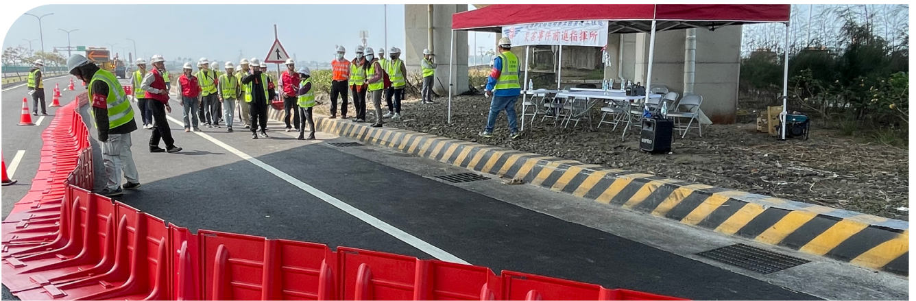
指揮所掌握災況在淹水路段設置防水擋板
