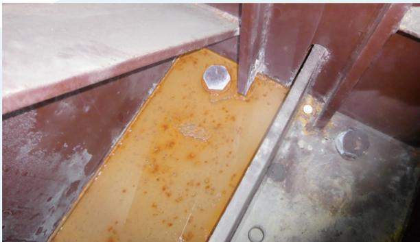
滲流水無法流出，造成箱內下翼板積水鏽蝕
