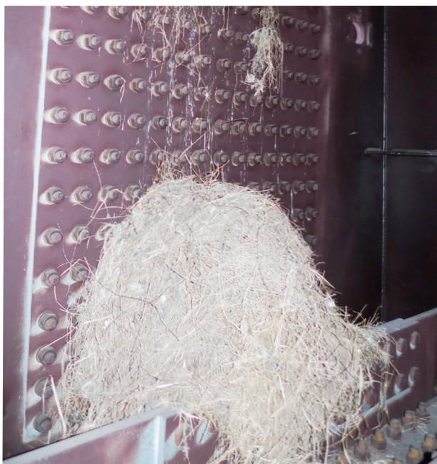
連接板間隙過大，造成鋼橋內部有鳥築巢的痕跡
