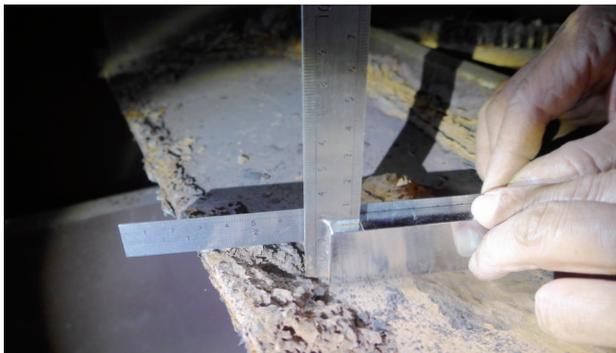
雨水無法順利排出，造成鋼板腐蝕現象
