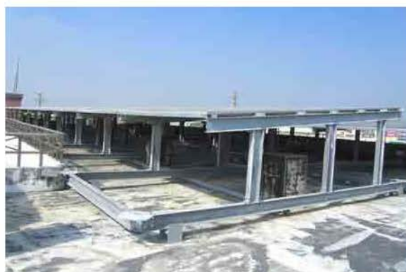
屋頂架設太陽能板
