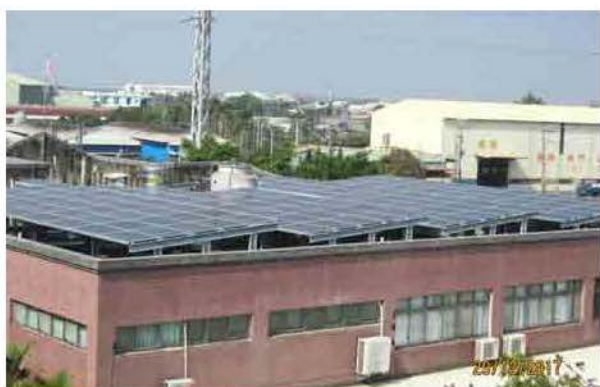
第三區養護工程處辦公室屋頂「種電」情形
