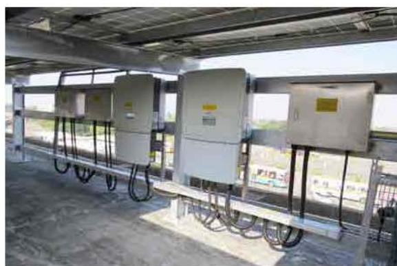
太陽光電設備之變流器及電表
