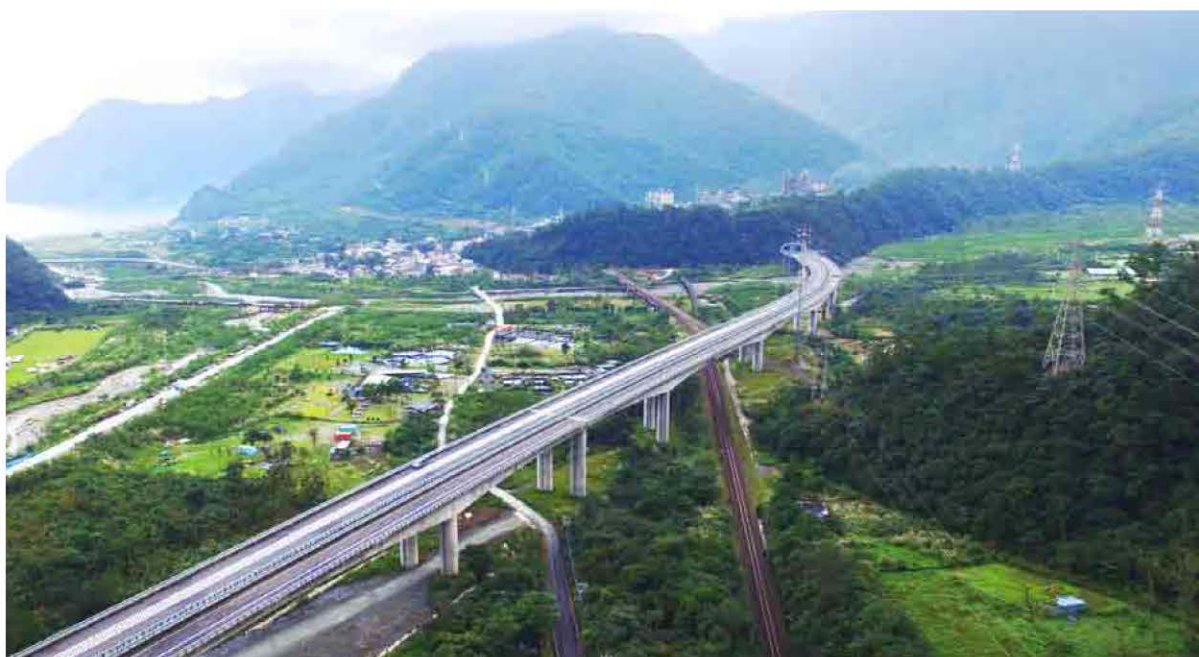
蘇花改蘇澳至東澳段—東澳東岳路段東澳北溪河川橋全景
