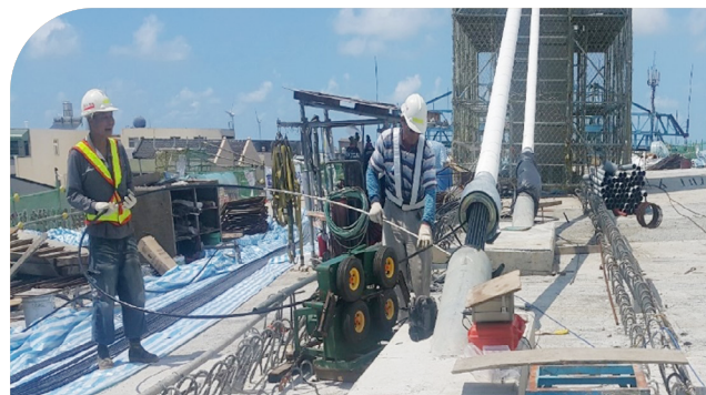
鋼絞線的穿線作業
