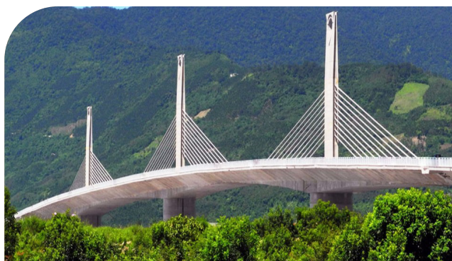
花蓮的新豐平大橋預計 8 月完工，是東部第一座斜張式特殊景觀橋梁
