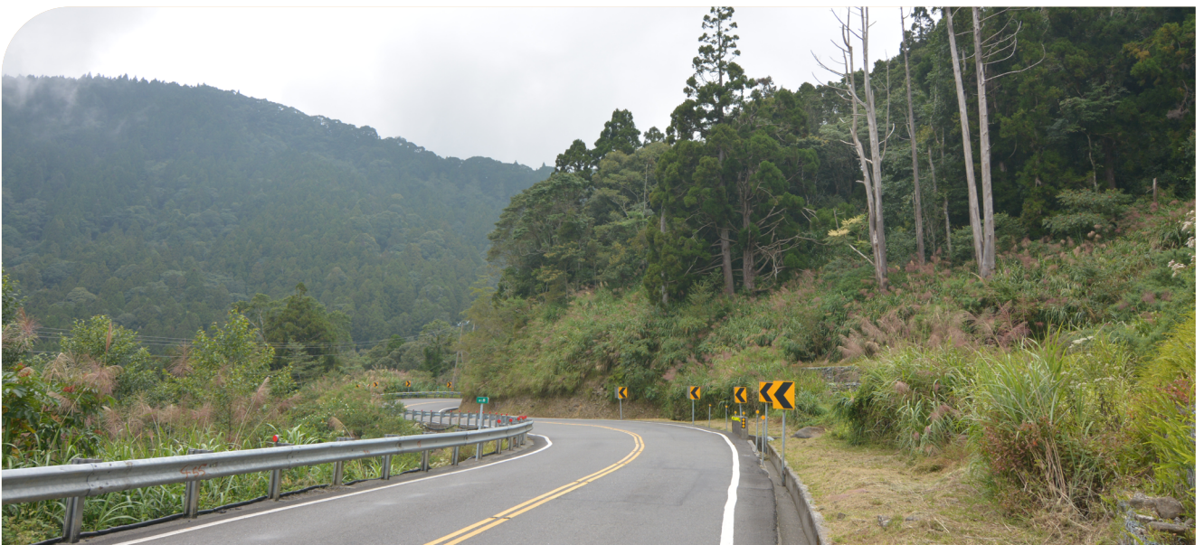
融入自然景觀，填石鞏固坡腳改善後路況
