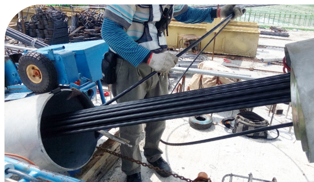
鋼絞線的穿線作業
