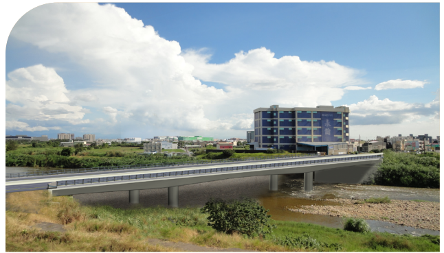
竹圍大橋方案模擬圖 (以三跨連續梁搭配預力混凝土箱型梁)
