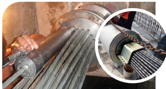
鋼絞線在箱梁內的施拉作業，施拉方式採單股施拉
