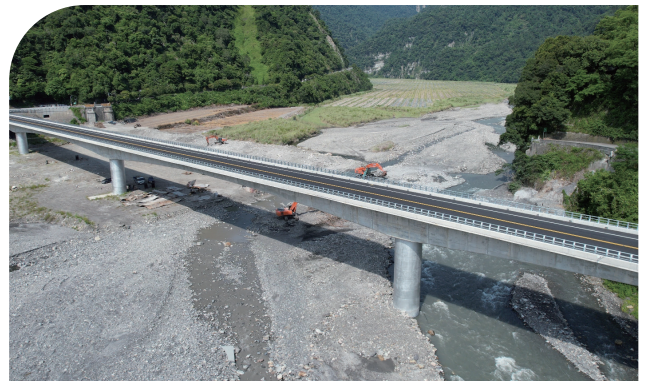
家源橋完工樣貌
