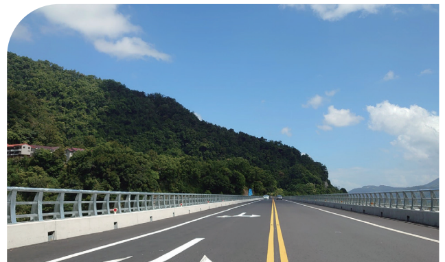
家源橋施工完成面貌
