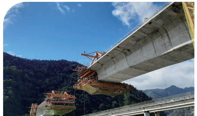
家源橋施工情形
