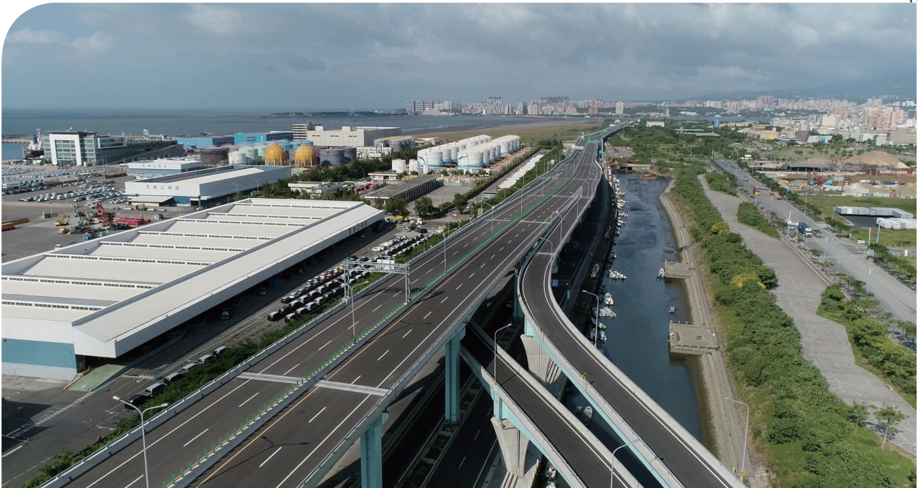
淡江大橋第1、2標八里端高架聯絡道空拍照片
