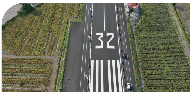
重新翻整路段設戰備道
