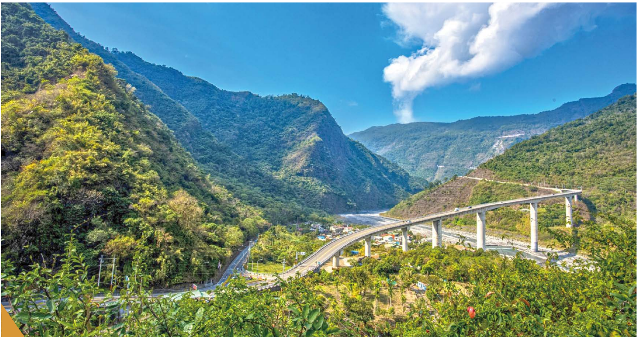
台24線32k谷川大橋日間景觀。
