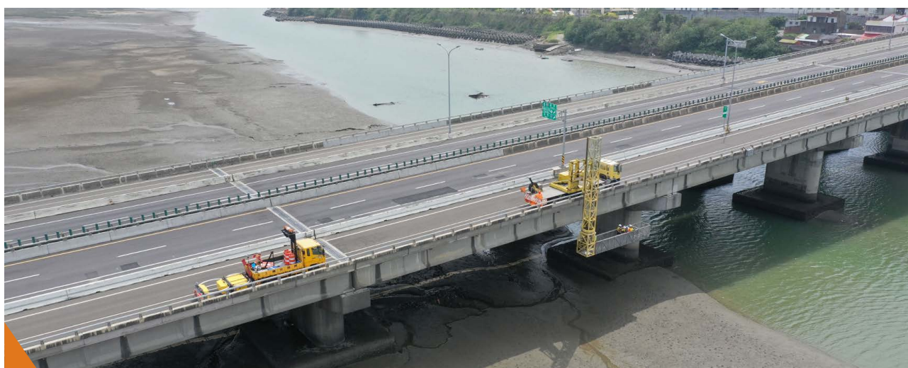
台61線後龍觀海大橋以橋檢車辦理橋檢作業。
