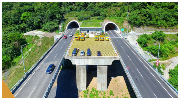
安朔高架橋橋台。 Abutment of Anshuo Viaduct.
