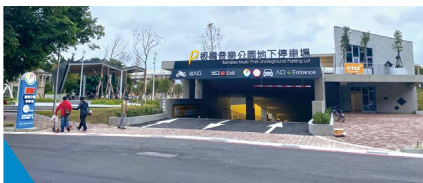
新北市音樂公園地下停車場成果照片（109.09.05完工）。
