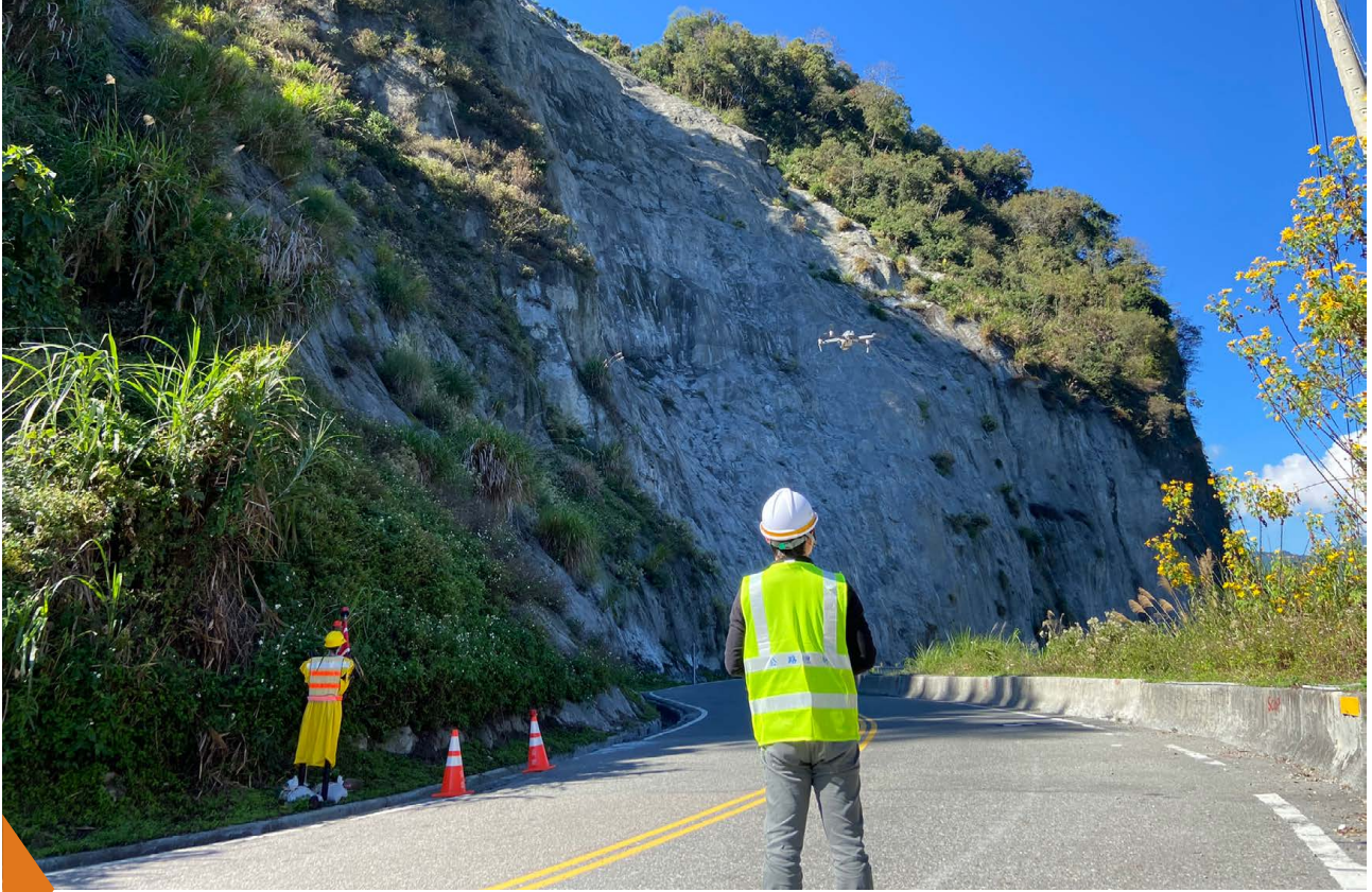
台21線115k+500B級邊坡第四季UAV巡檢。
