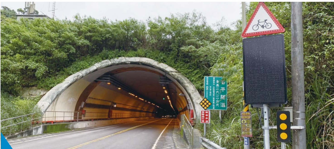
基平隧道北口告警系統。
