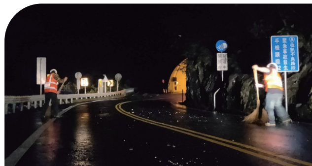
挑燈夜間清理易落石路段路面
