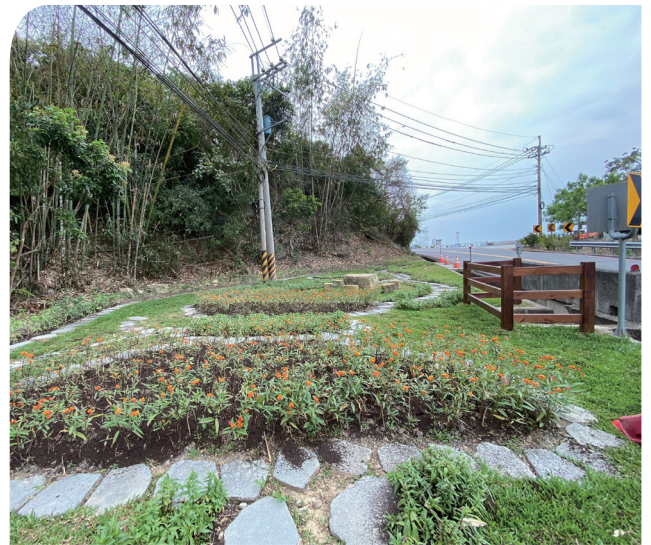
台3線347k+737隙地施工後
