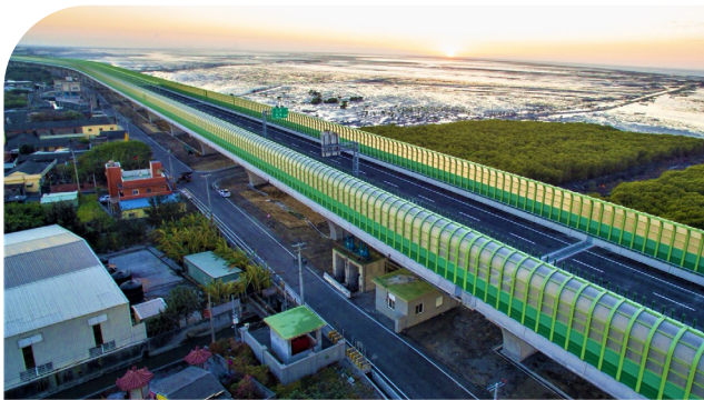
芳苑路段設置半包覆隔音牆降低噪音對生態的干擾，並防止鳥擊發生
