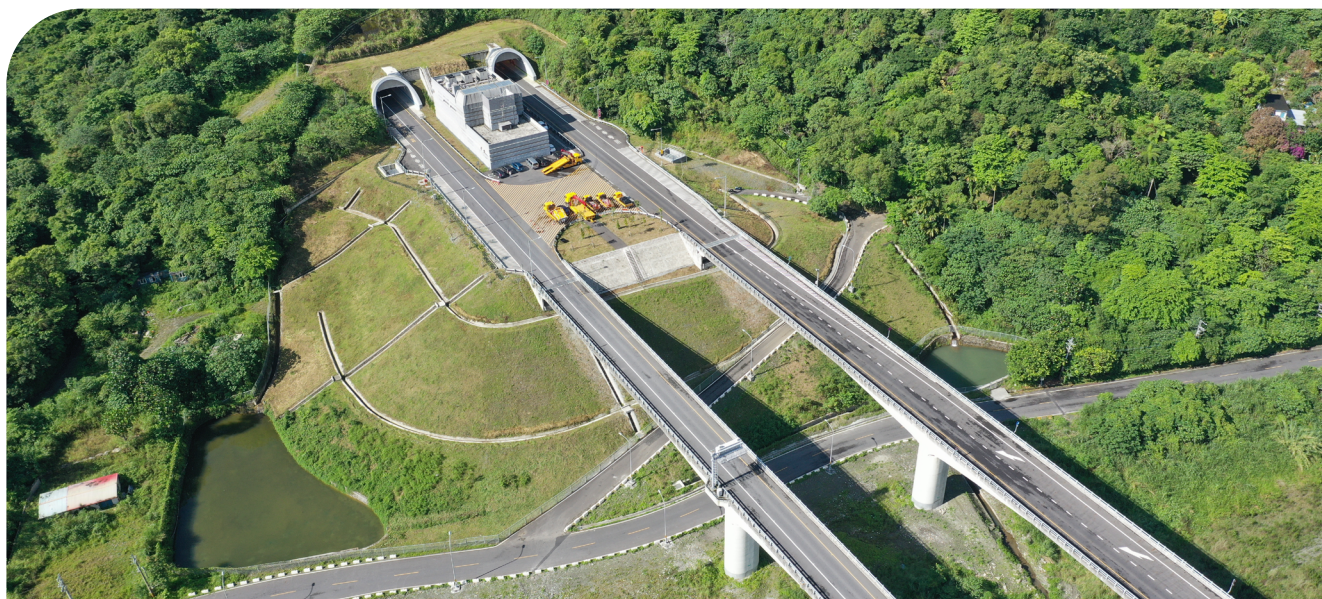
觀音隧道北口完工空拍照
