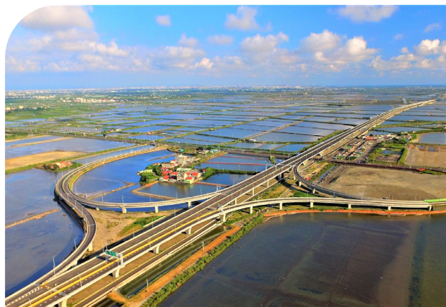
七股交流道採苜蓿葉形狀設計，巧妙保留當地八棟寮村落
