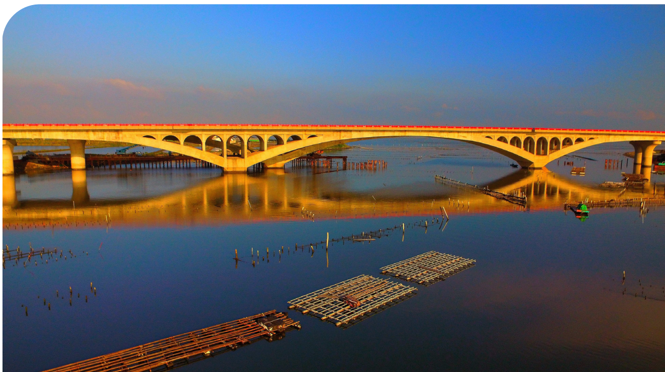
七股溪橋以歌德式拱橋設計加大跨距減少對生態及養殖漁業的衝擊
