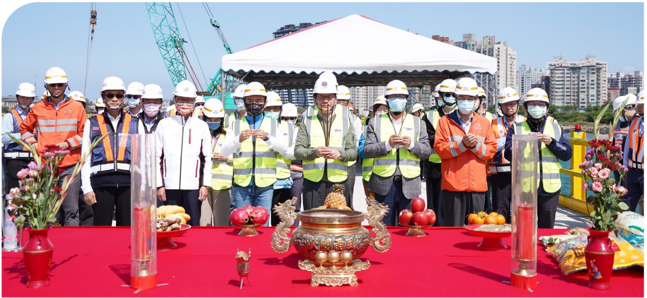
交通部長視察淡江大橋主橋塔首支基樁施工祈福
