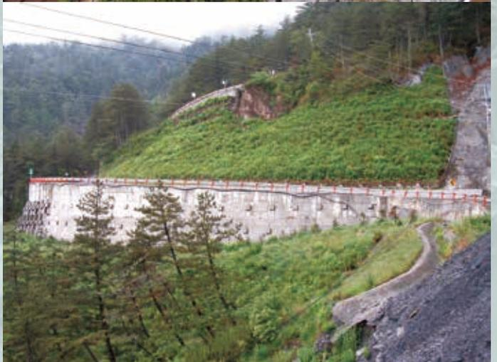
砌石工法是地球上最古老的建築工法之一，源自於先民與自然相處的智慧傳承，從希臘、羅馬的古老城堡到中國的萬里長城，都可以看到利用天然石塊建造出美麗、壯觀且持久的建物。有別於水泥灌漿的速成方式，砌石工法讓每個石塊相互依靠，卻又在彼此之間保留空隙，好讓空氣和雨水滲入土壤，是對大自然友善的多孔隙生態工法。
