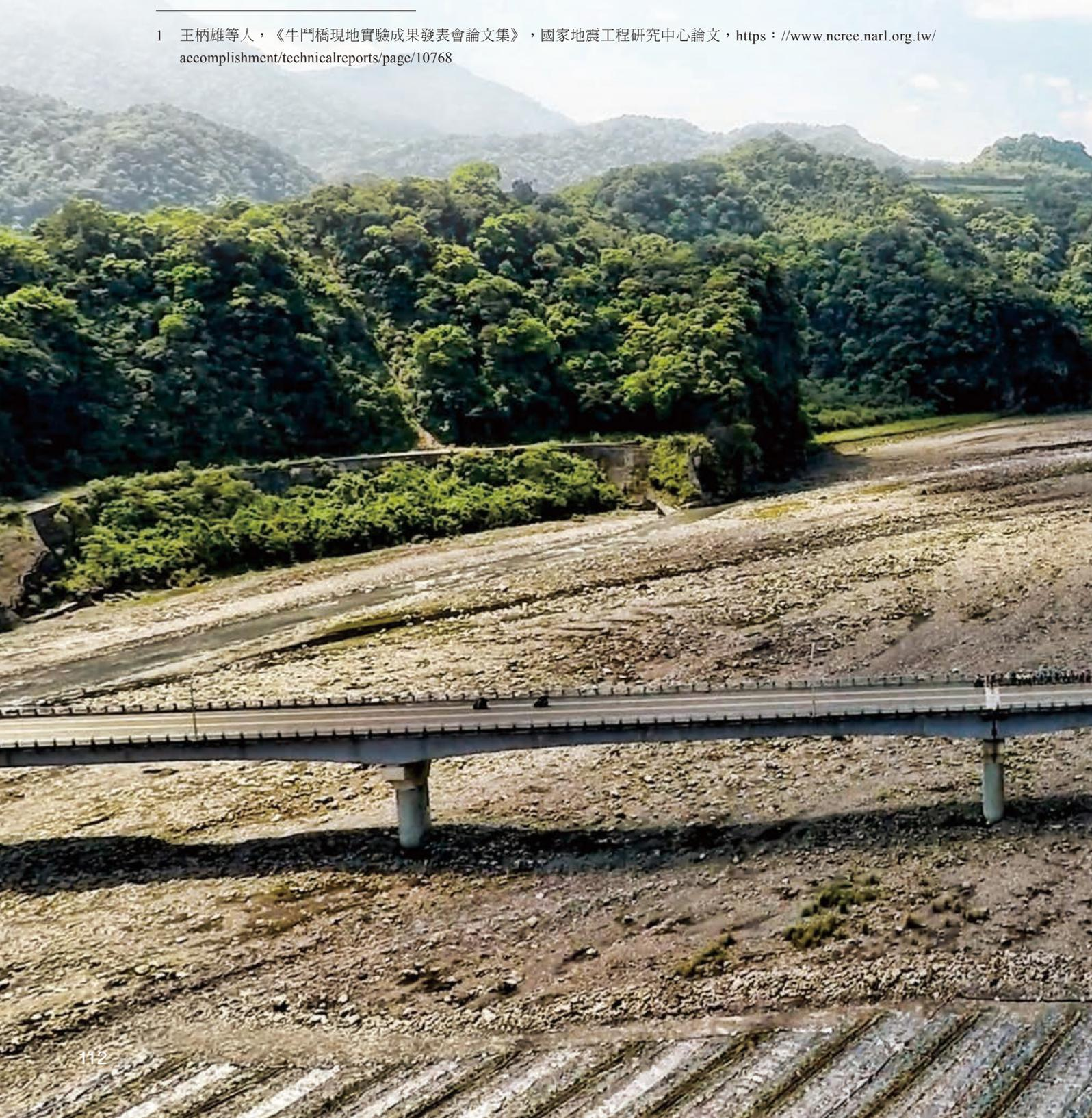
106年10月15日受卡奴颱風外圍環流影響，蘭陽地區遭逢豪雨侵襲牛鬥橋引道附近路基遭到淘空，但主橋毫髮無傷，經本處立即投入搶修後，於當日下午5時搶通，牛鬥橋又再一次通過天候嚴酷的考驗。
