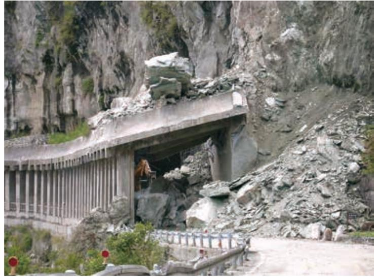
災害崩塌現場，大石壓壞明隧道
