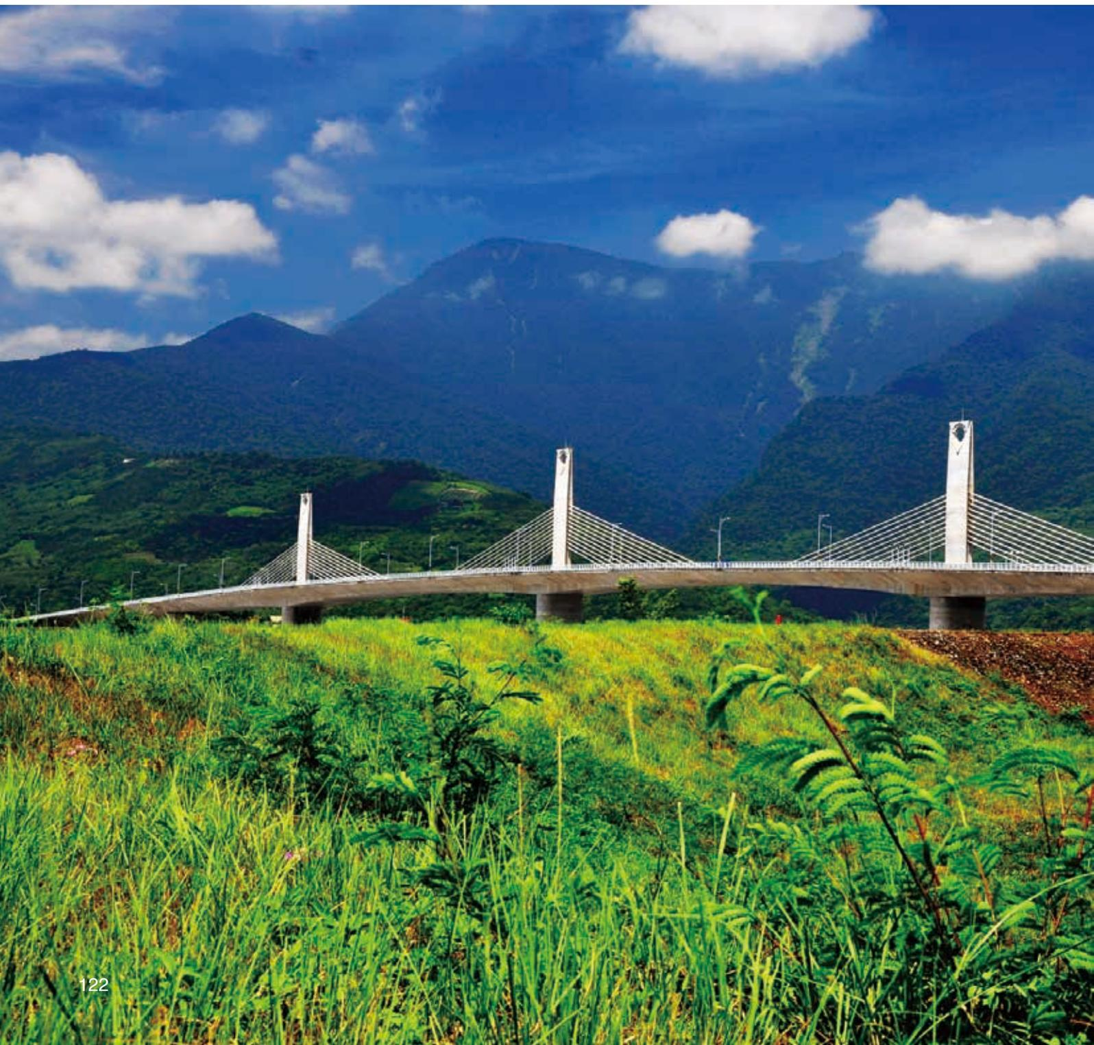
拉鋼索有效降低梁深需求，擺脫混凝土橋梁厚重的形象，中央橋塔配置11組斜索，兩側橋塔則配置各10組斜索，橋塔橋面以上全高30公尺，配合橋面弧形縱坡設計，橋梁中央橋面及橋塔益顯高聳，搭配白色的斜索，氣勢相當宏偉，型塑整體景觀呈現纖細輕巧之結構，全寬28.2公尺的橋面，也成為目前國內斷面寬度最大之脊背橋。
