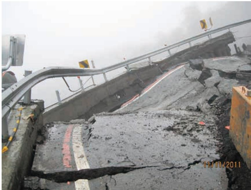
台7甲線41.7k迴頭彎下邊坡遭侵蝕造成路面塌陷
