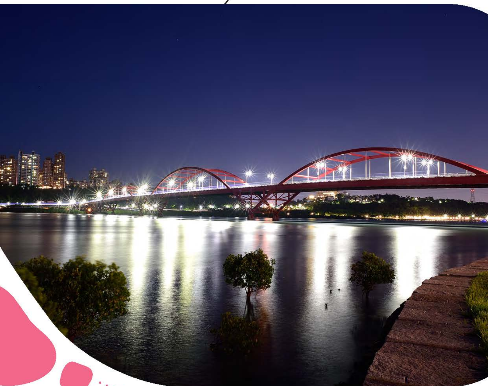
關渡大橋打通了八里與淡水之間的陸路通道
